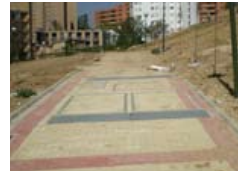
Inclinación lateral de cubierta
