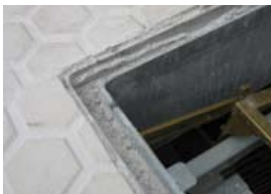
fig. 1 carril con hormigón
