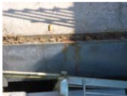
fig. 2 carril con impurezas
