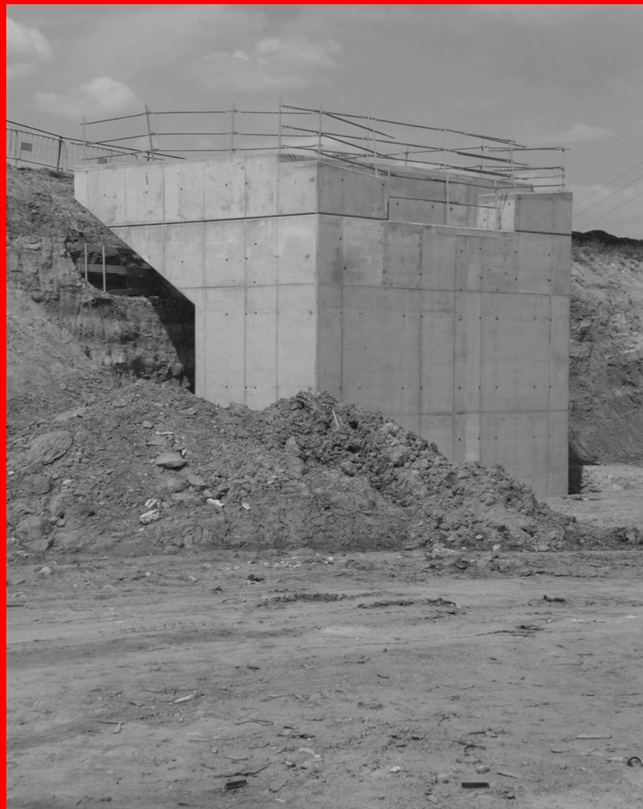
Aldesa / Adif. Nou Tram de l'Ave a Montornés del Vallés. Execució de Pilars i Mensures en Ponts.
