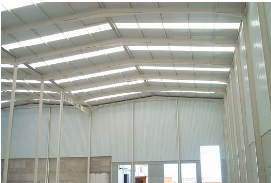
Nave para almacenamiento de aceitunas (Monturque)
