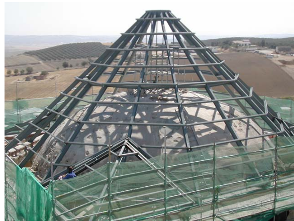
Cubierta de Iglesia Santaella (Córdoba)
