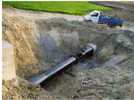
Pieza especial de calderería.
