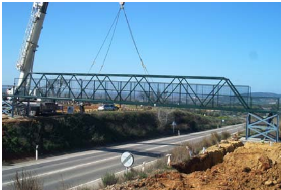
Construcción de pasarela para paso de carretera
