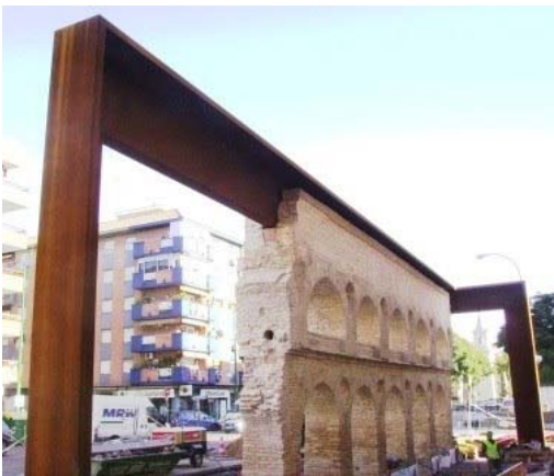
Estructura Caños de Carmona (Sevilla)
