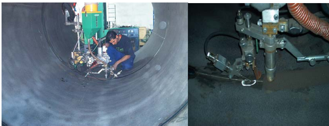
Soldadura automática con arco sumergido
