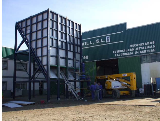
Silos para naranjas, construcción en nuestros talleres
