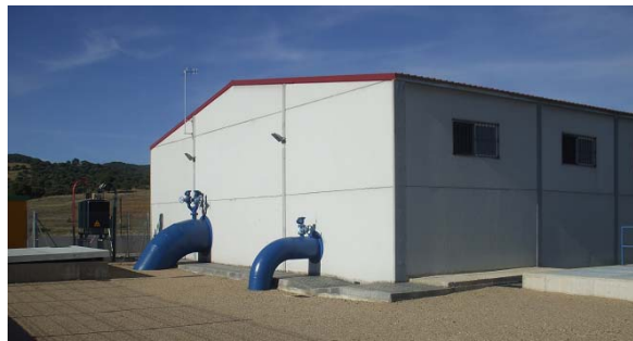
Estación de bombeo.
