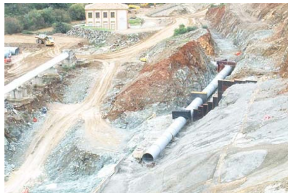
Montaje en Presa de la Breña II
