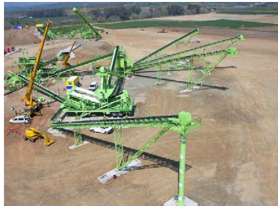
Montaje de planta de áridos
