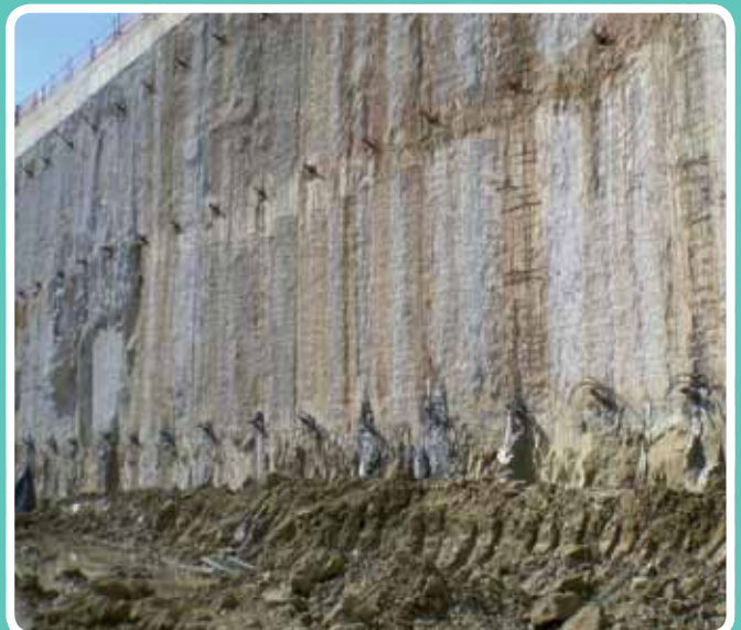
(Sellado de anclajes) Replanteo de anclajes. Hotel Fuengirola, Málaga
