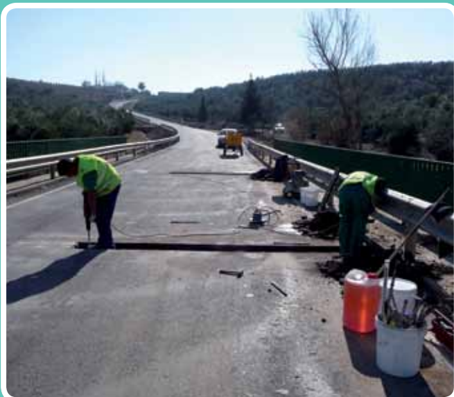
(Replanteo de perforaciones y limpieza) Perforaciones con vida
