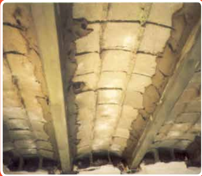
Reparación de viguetas con aluminosis. Sistema patentado por Reepox
