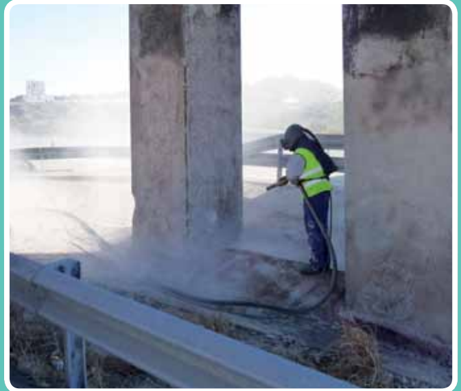
Limpieza de superficie
