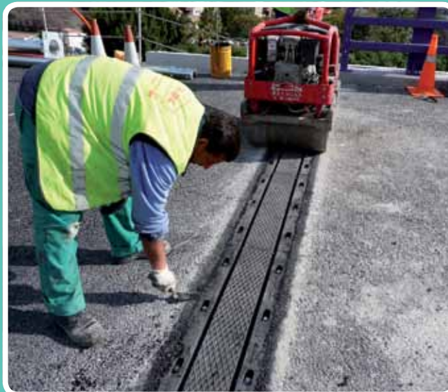
(Relleno banda transición y par de apriete) Compactación de módulos UTE Valmiñor
