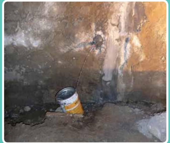
(Juntas muro de pantalla) Eliminando filtraciones Metro de Málaga
