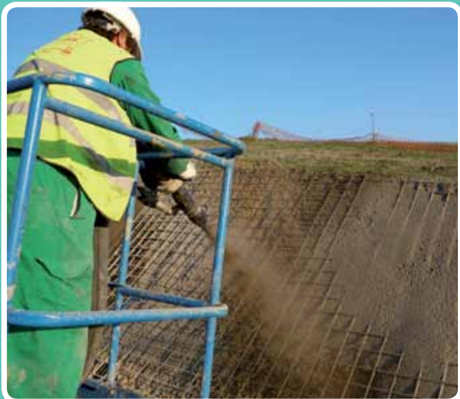
(Maquinaria estática / vía húmeda) Proyección desde canasta. SACYR-PRINUR, pedregalejo, Málaga
