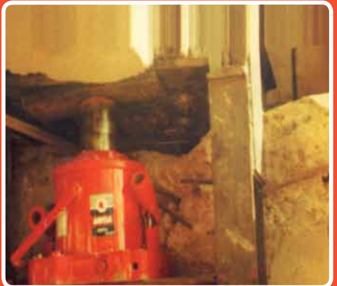
Levantamiento con gatos hidráulicos de vigas puente
