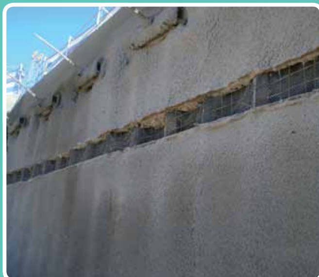
(Maquinaria estática / vía húmeda) Gunita de espesor hasta alinear UTE San Fernando, soterramiento línea férrea
