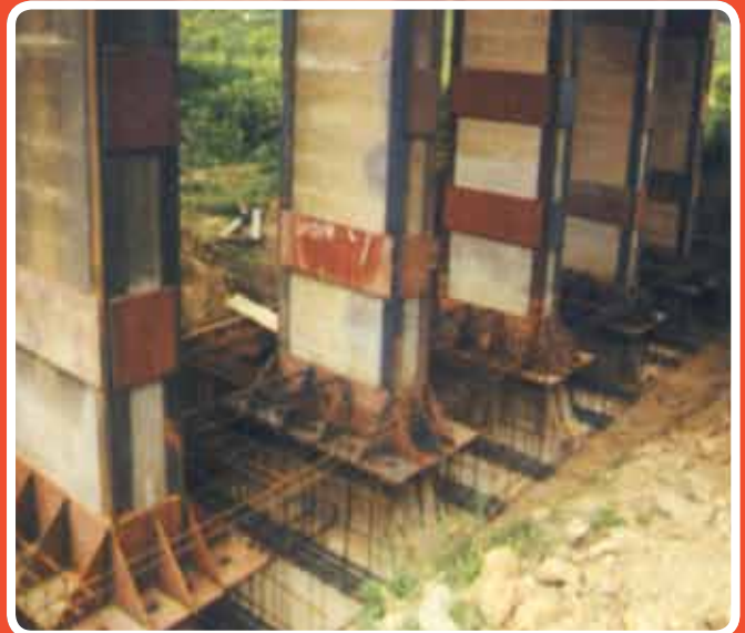
Refuerzo y arriostrado de pilares. Puente de Sevilla a San Juan de Aznalfarache
