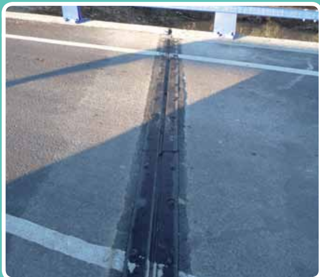
(Aspecto final) Junta. Autovía de Almazora
