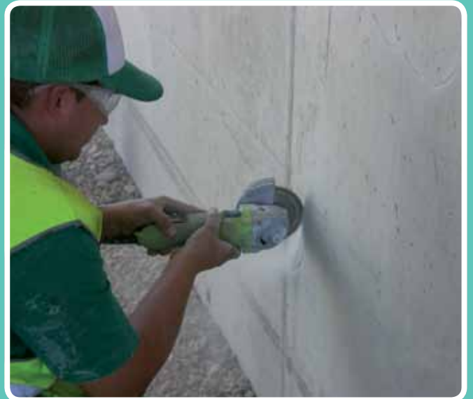
Colocación de inyectores y apertura. Ferrovial Montoro, Córdoba
