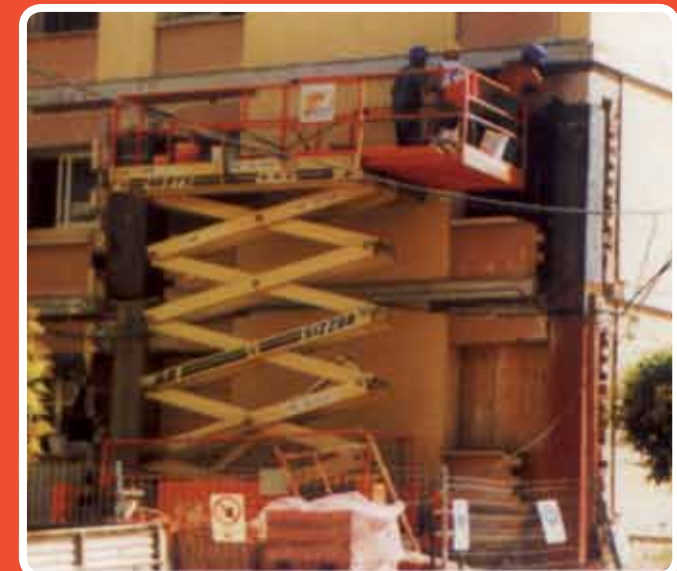
Reparación de estructuras de viviendas. Bda. San Francisco de Sales (Elda)
