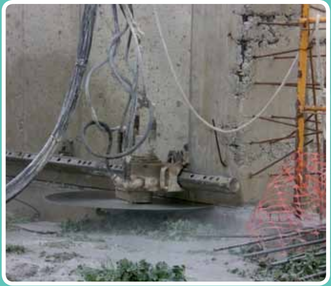
(Máquina rural) Cortando muro de hormigón. Centro Comercial Alsur. Granada
