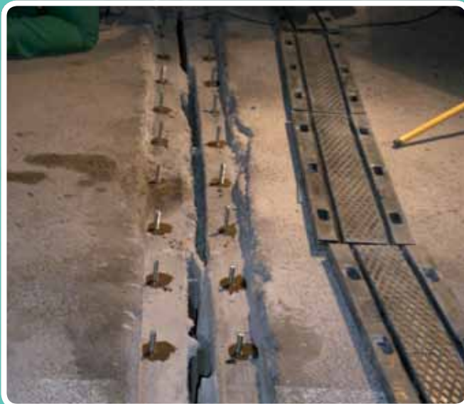
(Anclado con resina epoxi) SAFYR, acceso al Aeropuerto
