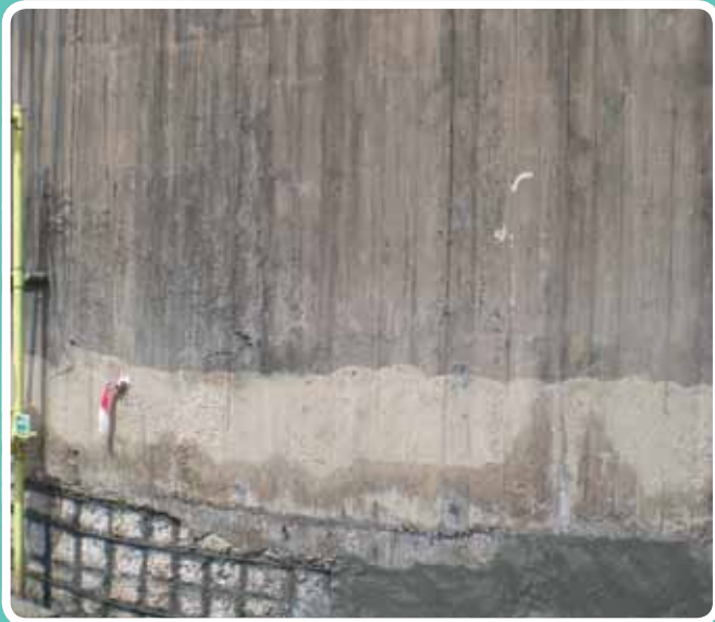
Aplicación de mortero nanocrete. Siderúrgica Sevillana
