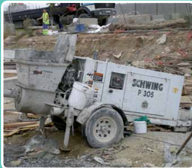
(Maquinaria estática / vía húmeda) Maquinaria hidráulica. UTE Nueva pista, Aeropuerto de Málaga
