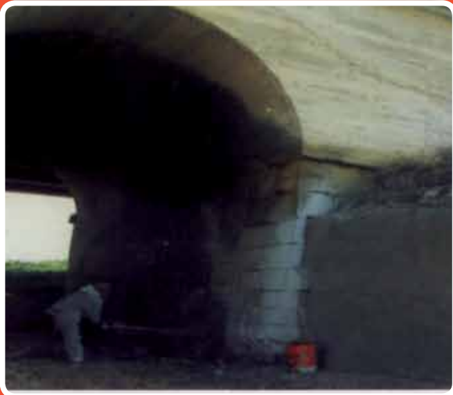
Gunitado Bóvedas de puente. Carretera Nacional 630
