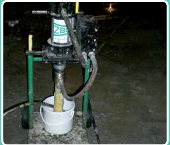
(Sellado de anclajes) Equipo de inyección. Parlamento de Andalucía, TECONSA
