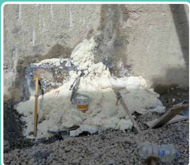
(Juntas muro de pantalla) Taponado. Grupo Terratest C/ Armendáriz
