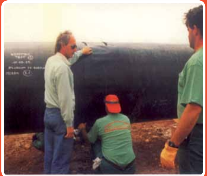
Tratamiento de juntas de gaseoducto. Revestimiento
