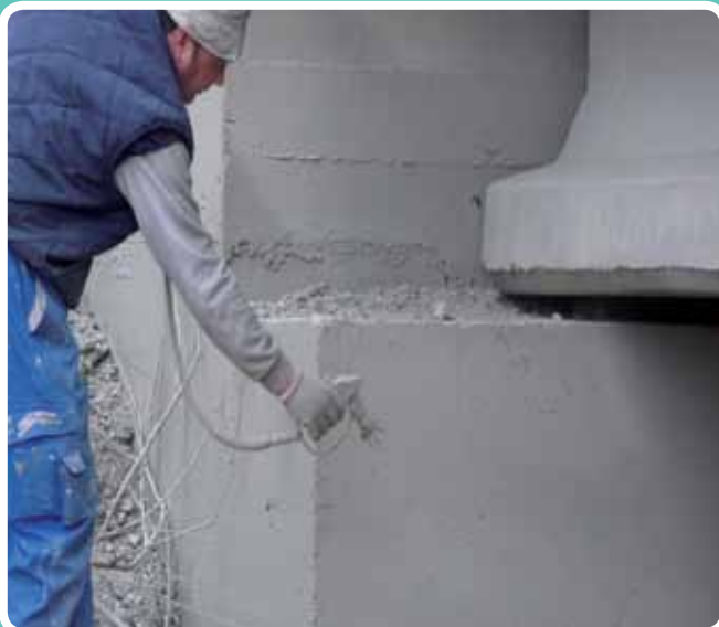
(Revestimientos anticarbonatación) Autovía Almazora
