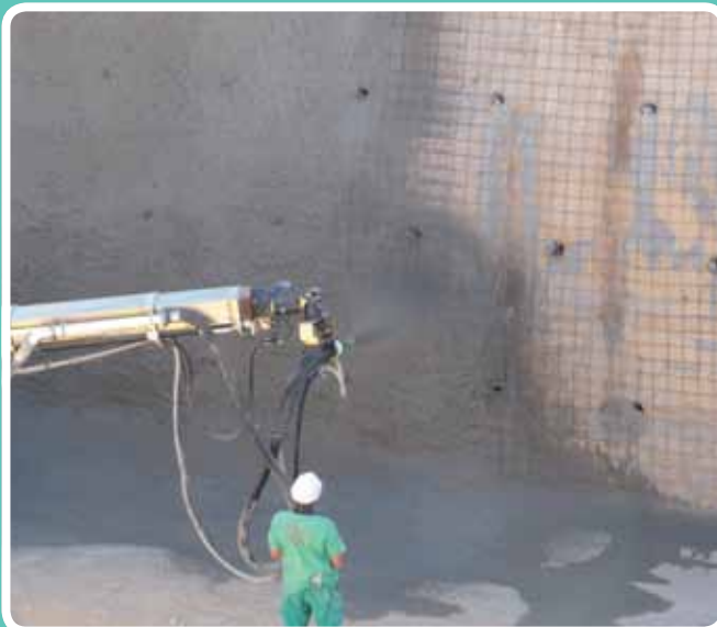
Estabilizacion de talud en Ponferrada de Autovia A-6
