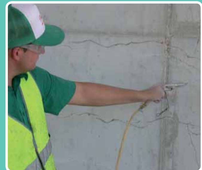
Limpieza exhaustivas. Ferrovial Montoro, Córdoba
