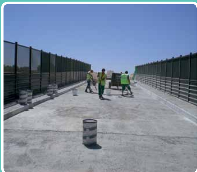
(Aplicación de mortero impermeable) Impermeabilización de tableros. Línea de Alta Velocidad Plataforma de Levante
