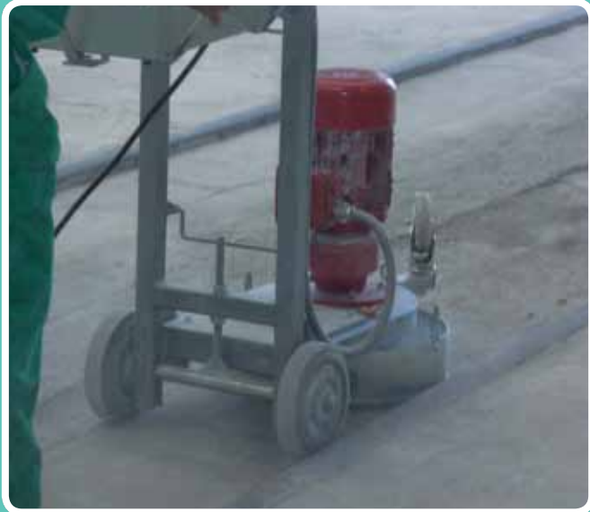
(Pavimentos industriales) Apertura de poro. UTE Metro de Sevilla
