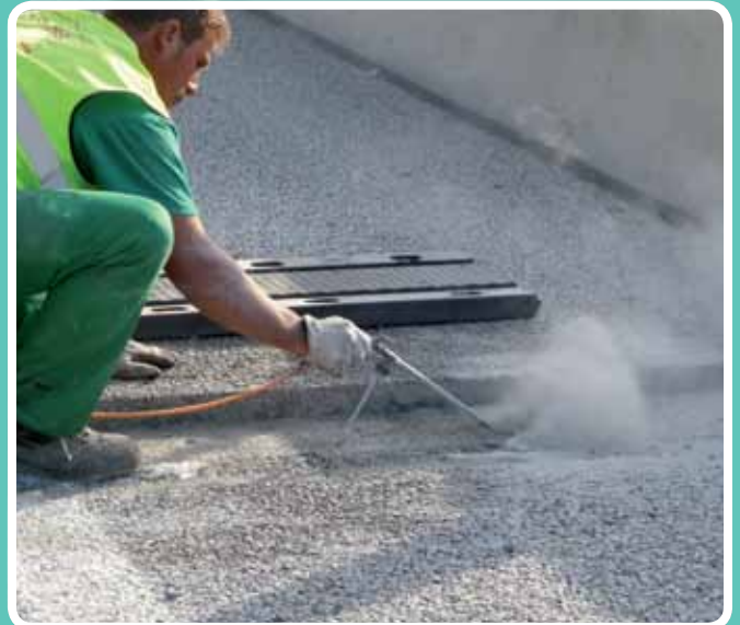
(Replanteo de perforaciones y limpieza) Limpieza cama nivelación JICARSA, a-334
