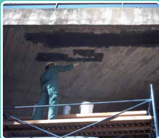
(Refuerzo con fibra de carbono) Aplicando hoja mbrace. SEOP Urbanización Fuengirola
