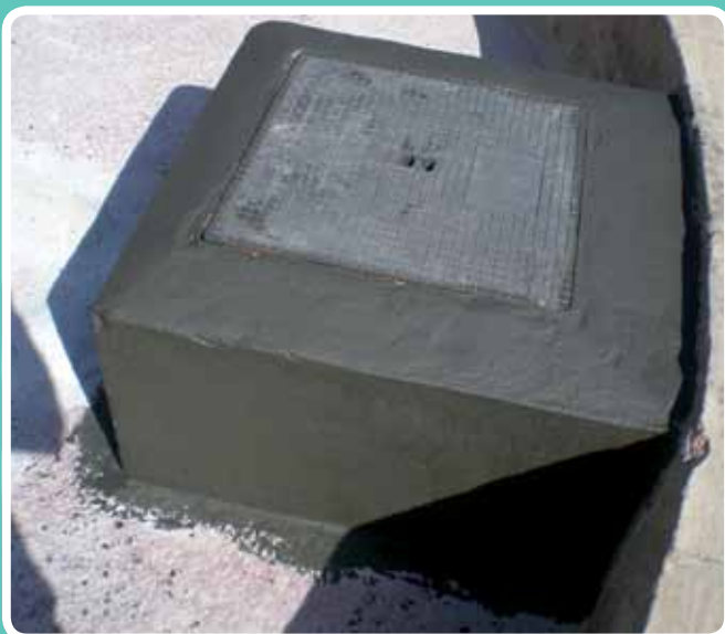
(Revestimiento cementoso) Impemeabilización de arqueta. IMES-API Ayuntamiento de Málaga
