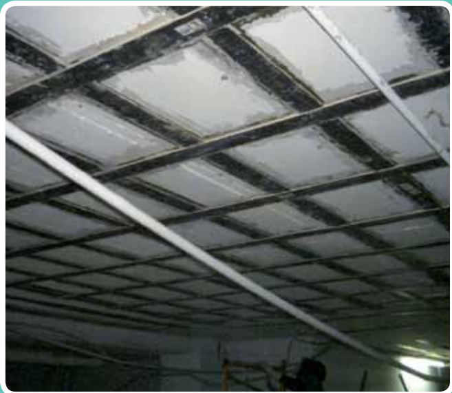
(Refuerzo con fibra de carbono) Sistema de fuerza mediante fibra de carbono
