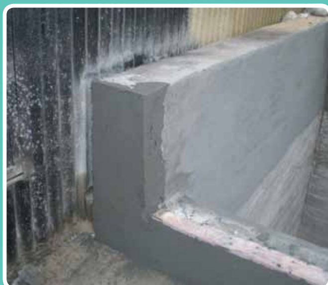
Reparación reconstrucción. Siderúrgica Sevillana
