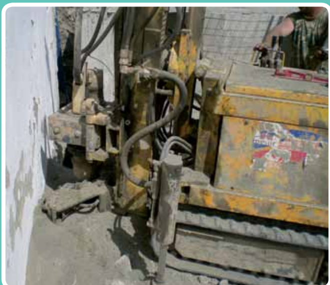
Perforando terreno. Obra Const. San José, Albuñol, Granada
