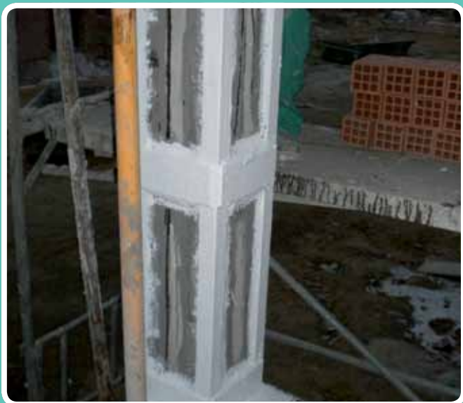
(Refuerzo con elemento metálico) Acabado el refuerzo, pintura ignífuga. Constructora San José, C/ Don Fadrique, Sevilla
