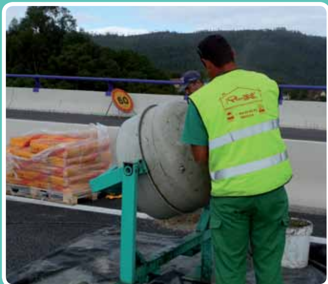
(Aplicación de mortero de nivelación) Amasando mortero. API Conservación,
