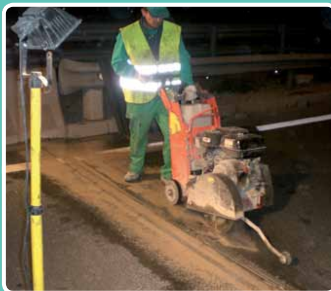
(Corte y cajeo) Cortando de noche. COMSA Huelva
