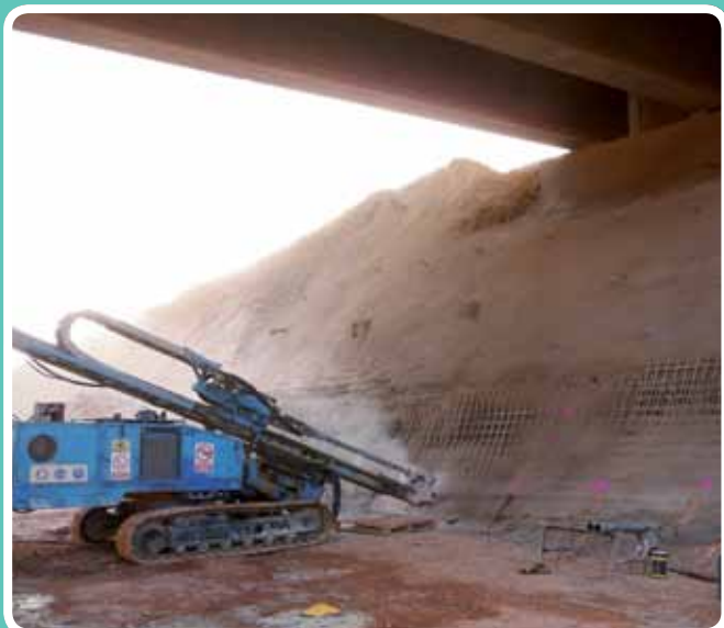
Bulonado para estabilizacion de taludes en variante Puerto LLano (Castilla la Mancha)
