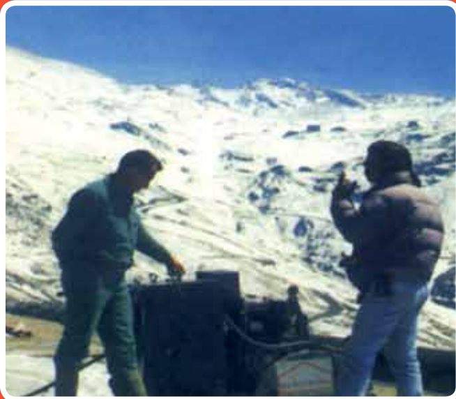
Corte y demolición de hormigón. CAR Sierra Nevada (Granada)
