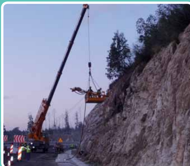
Bulonado en altura. Autovía a Boiro, Santiago de Compostela
