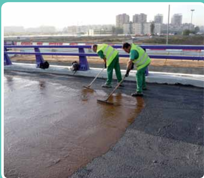
(Aplicación de mortero impermeable) Aplicándolo. Nuevo acceso al Puerto de Málaga
