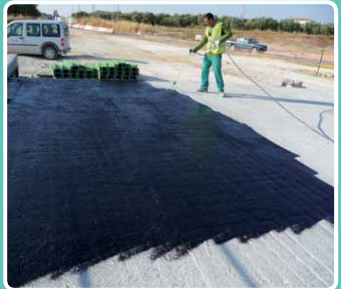
Impermeabilización tablero mediante airless en variante Marchena (Sevilla).Tif
