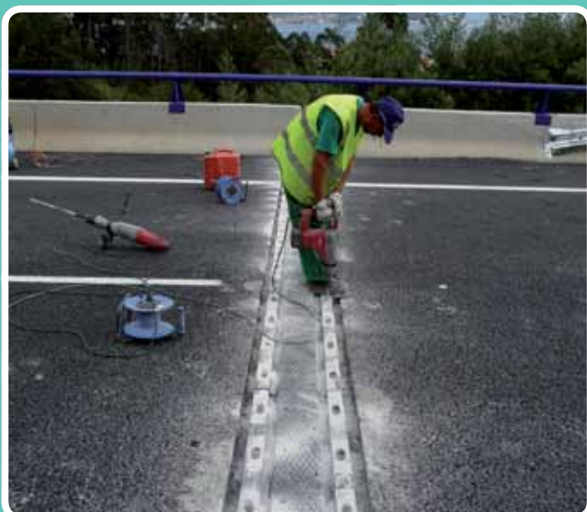
(Replanteo de perforaciones y limpieza) Taladrando
