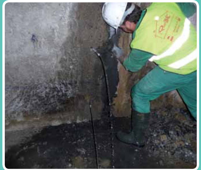
(Juntas muro de pantalla) Aplicando en mortero rápido. Ampliación Aeropuerto de Málaga
