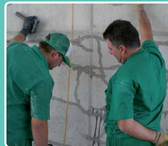
Resina epoxi de alta viscosidad. Ferrovial Montoro, Córdoba
