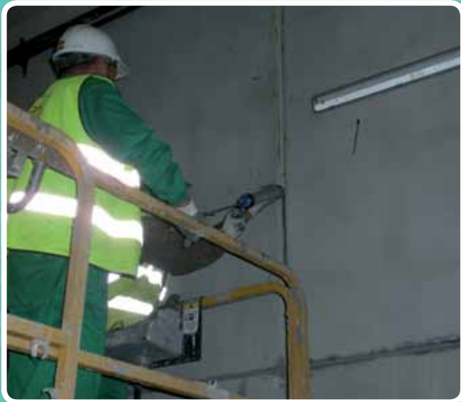
Aplicando masillas de poliuretano. UTE Metro de Sevilla
