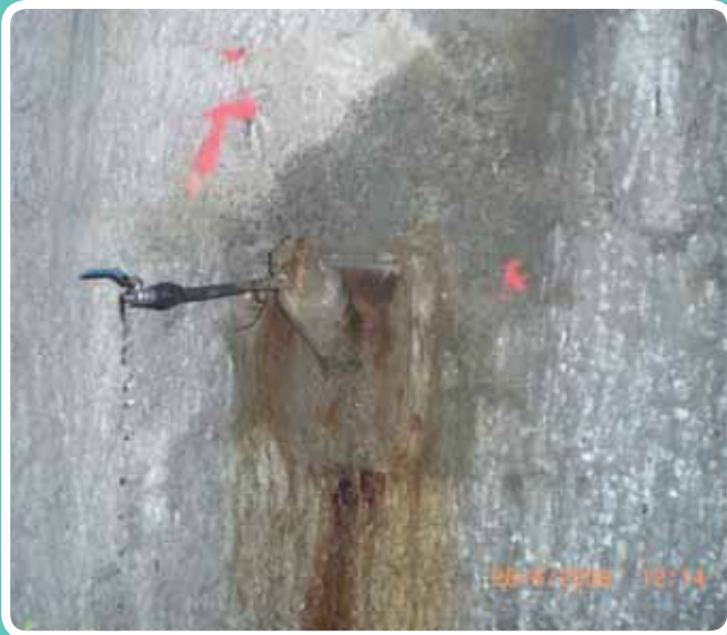
(Sellado de anclajes) Canalización de agua. Nueva Sede de Urbanismo, Dragados, Málaga
