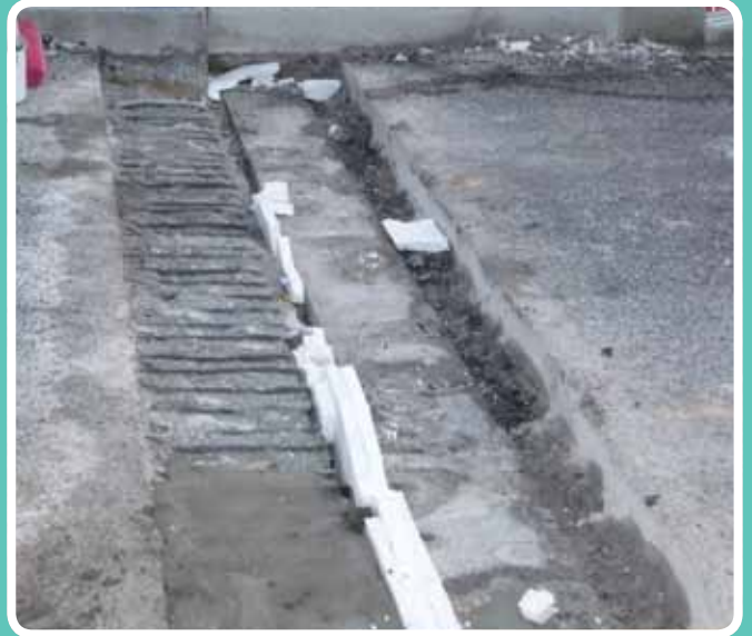
(Aplicación de mortero de nivelación) Saneo íntegro al tablero ALDESA, Málaga
