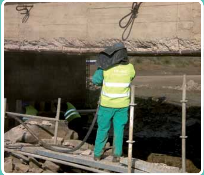
Limpieza chorro. ACSA, rehabilitación Puente Riopiedras
