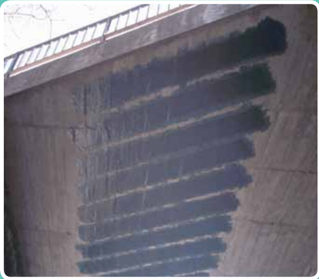
(Refuerzo con fibra de carbono) Refuerzo con hoja de carbono
