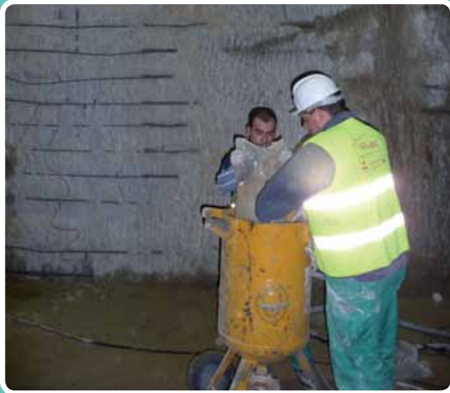
Equipo chorreando armadura vista. Integración del AVE en Málaga
