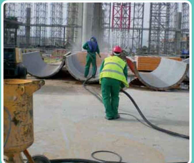
Equipo de chorreo. Ampliación Aeropuerto Málaga
