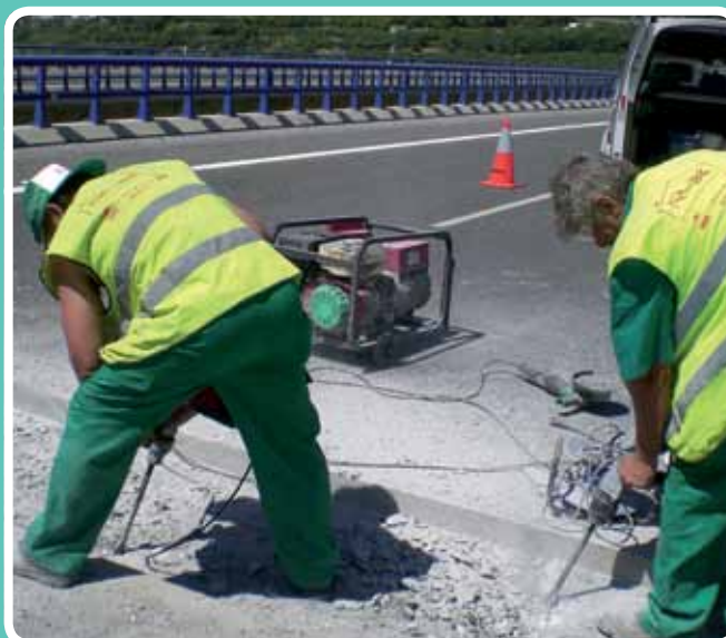
(Corte y cajeo) Equipo picando hormigón. GRUPISA, A-7 (Torrox-Málaga)
