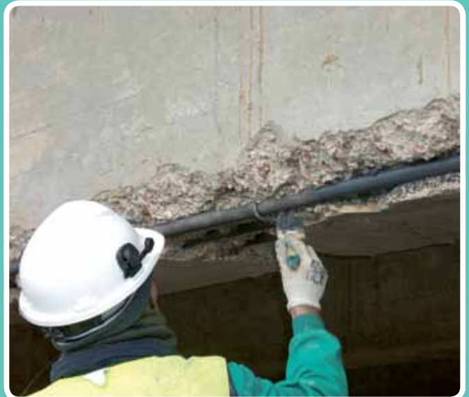
Pasivación armaduras
