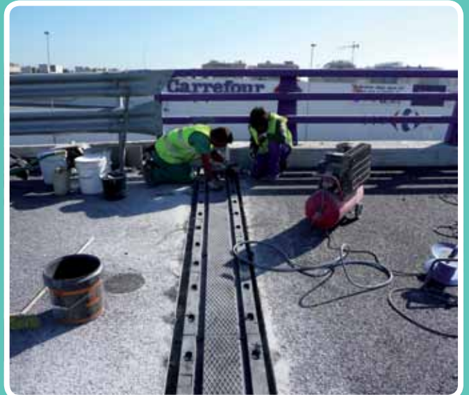
(Colocación de juntas) Colocación de módulos. SAFYR, acceso al Aeropuerto
