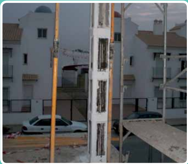
(Refuerzo con elemento metálico) Refuerzo vivienda. Intedis del Sur, Sevilla
