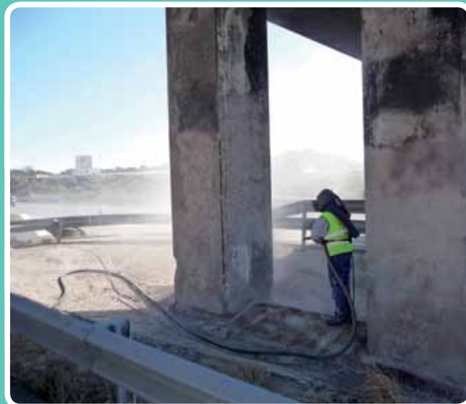
Chorro sobre pilas. Ministerio de Fomento, Málaga
