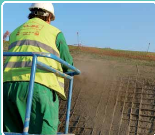
(Maquinaria estática / vía húmeda) Cubriendo la malla. Promociones TEZANOS, Madrid
