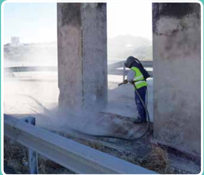
Limpieza de superficie
