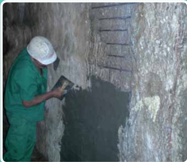
Aplicando el mortero nanocrete
