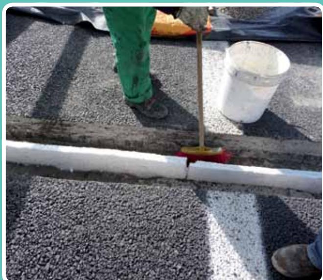
(Aplicación de mortero de nivelación) Colocación de porexpan y limpieza tablero. UTE SANDO CONACON, Plataforma de Levante
