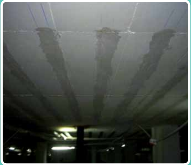
(Refuerzo con fibra de carbono) Recién lijada la superficie
