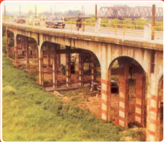
Reparación de estructuras. Puente de Sevilla a San Juan de Aznalfarache
