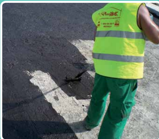
(Aplicación de resina-brea) Brea epoxi. Autovía de Alanzora, tramo Finex-Albox
