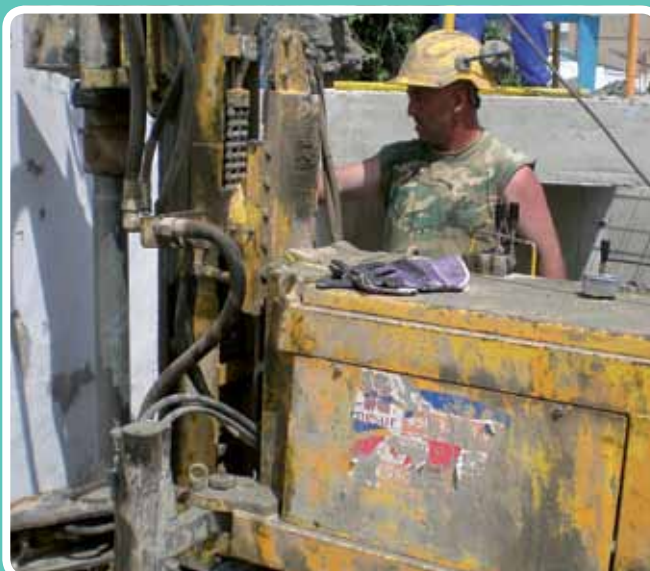
Trabajos de difícil acceso. Obra Const. San José, Albuñol, Granada
