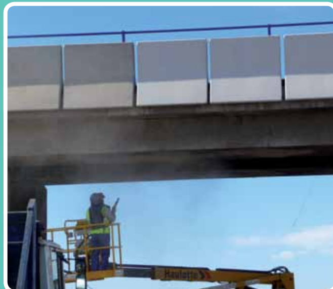
Limpieza de vigas. Ministerio de Fomento, Málaga
