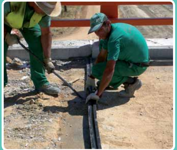
(Colocación de juntas) Colocación perfil expansivo. UTE Cuellar, Segovia
