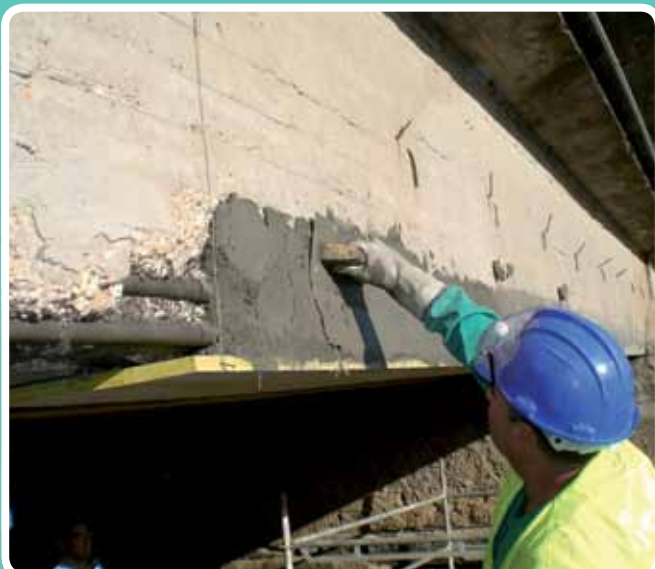
Reparación jácena frontal
