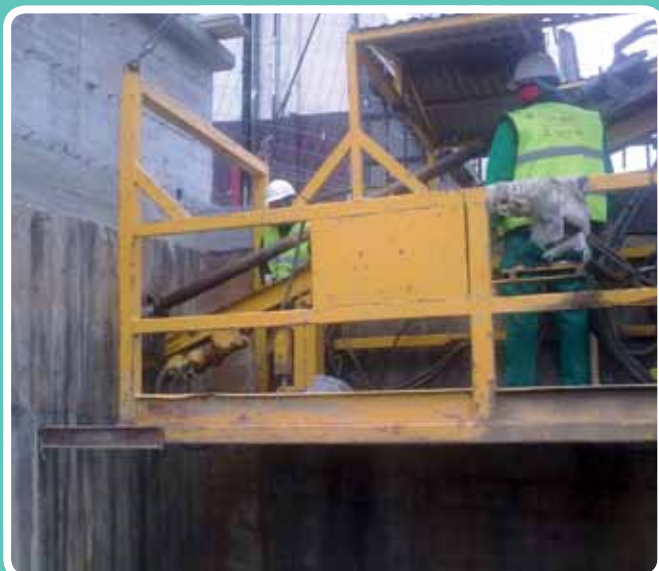
Bulondaje de muro con cesta en Mondragon (Pais Vasco)
