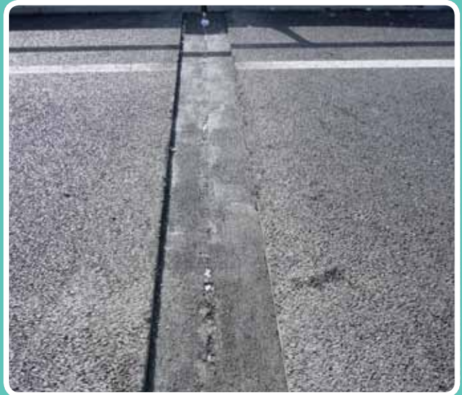
(Aplicación de mortero de nivelación) 24 horas después. . ALDESA, Nuevo acceso Barriguilla, Málaga
