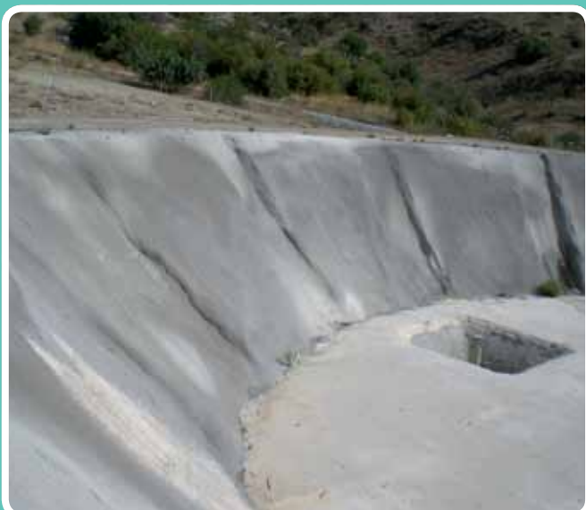
(Maquinaria estática / vía húmeda) Depósito proyectado con gunita. CORSAN CORVIAN, Pizarra, Málaga
