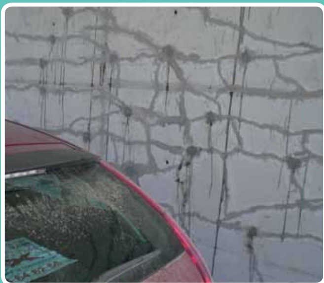
Fisuras inyectadas. Ferrovial Montoro, Córdoba
