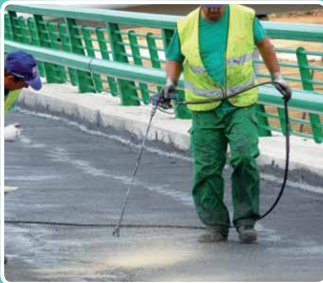
Impermeabilización tablero airless con arido espolvoreado variante Miraflores (Algeciras)
