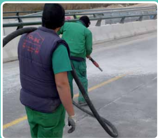
(Limpieza de hormigón) Chorreando hormigón. Autovía de Alanzora
