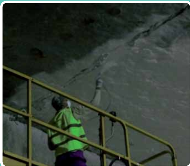
(Revestimiento ignífugo) Sistema AIR-LESS. Integración AVE Málaga, tramo estación del AVE
