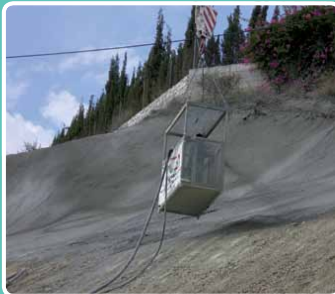
(Maquinaria estática / vía húmeda) Proyección gunita corona talud SACYR-PRINUR, pedregalejo, Málaga
