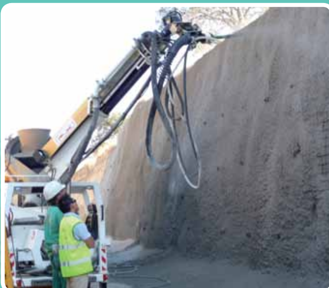
Estabilización de talud en Colegio, Bobadilla del Monte (Madrid)
