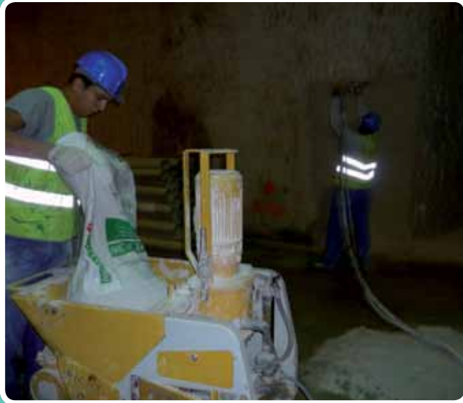
(Proyección de mortero ignífugo) Máquina de amasar el mortero. Integración del AVE, Málaga, tramo Antequera-Málaga
