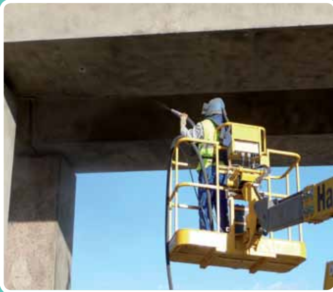
(Revestimientos anticarbonatación) Limpieza con chorro de árido. Ministerio de Fomento, Málaga
