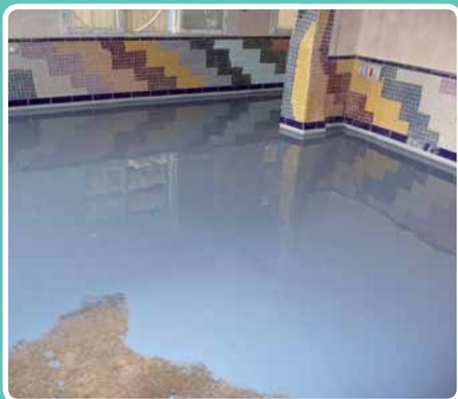
(Pavimentos decorativos) Imprimado con resina. Recuperaciones Ballesteros, nueva sede
