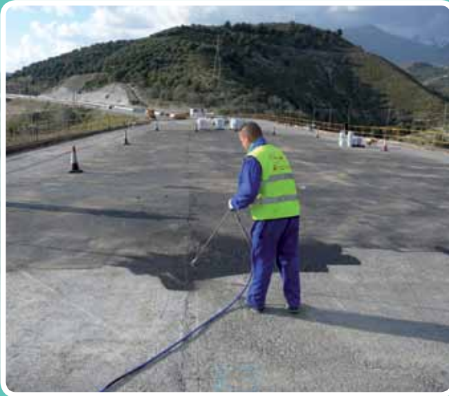
Impermeabilización tablero Acciona Izbor (Granada)
