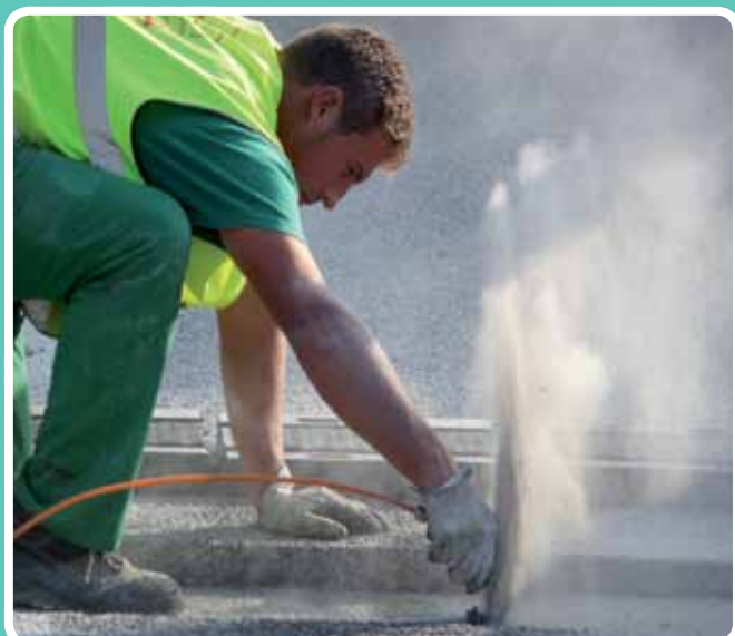
(Replanteo de perforaciones y limpieza) Limpieza de perforaciones
