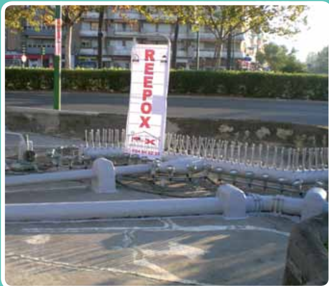
Fisuras de losa reparadas. Fuente de la Gran Plaza, Sevilla
