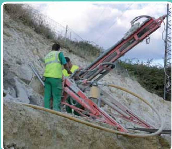
Bulonado con maquinaria estática. UTE El Escorial, Madrid
