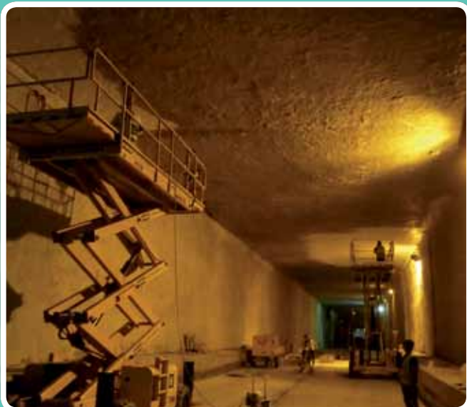
(Revestimiento ignífugo) Replanteo equipos Integración AVE Málaga, tramo estación del AVE
