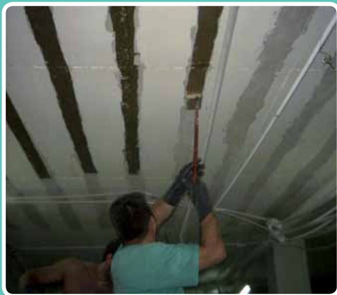
(Refuerzo con fibra de carbono) Imprimando toda la superficie lijada. Ayuntamiento de Montoro, Córdoba
