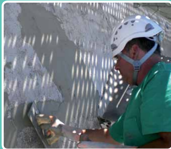
Aplicación de morteros tixotrópicos. Albergue Militar, Sierra Nevada
