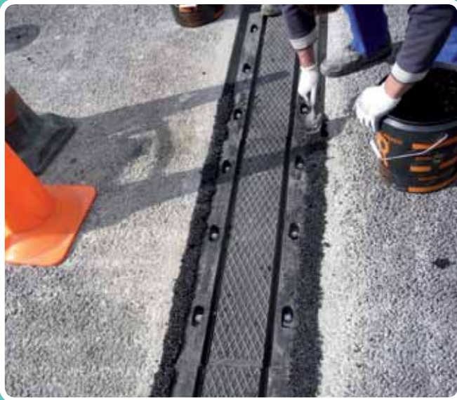
(Relleno banda transición y par de apriete) Relleno banda transición. ISOLUX-CORSAN Autovía A40
