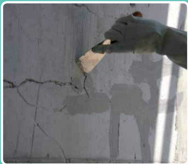
Sellando con mortero epoxi. Ferroviario Montoro, Córdoba
