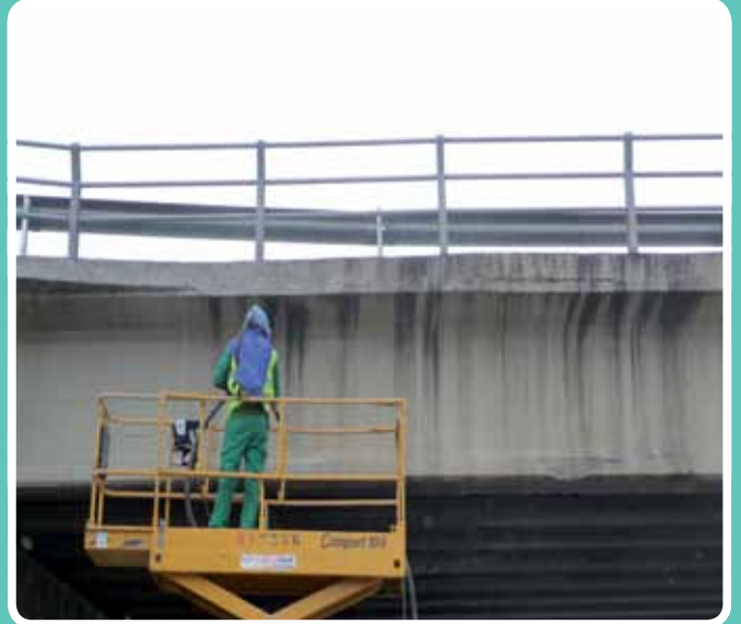
(Revestimientos anticarbonatación) Limpieza previa. Grupisa MA-24
