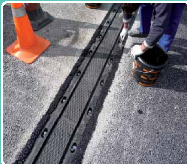
(Relleno banda transición y par de apriete) Mortero en frío y emulsión bituminosa GRUPISA infraestructuras
