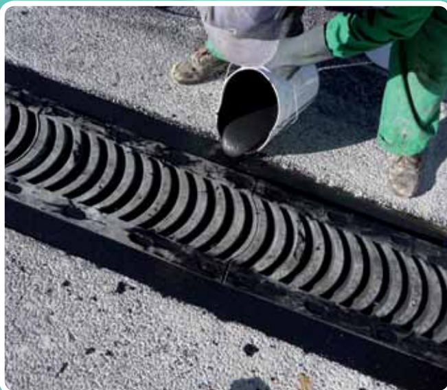
(Relleno banda transición y par de apriete) Relleno banda con mortero flexible ISOLUX-CORSAN Autovía A40
