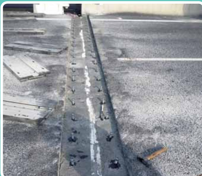
(Anclado con resina epoxi) Replanteo de anclajes. Ministerio de Fomento, Carreteras del Estado
