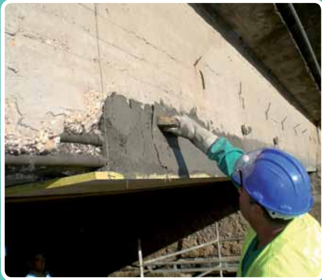
Reparación jácena frontal. ACSA, rehabilitación Puente Riopiedras
