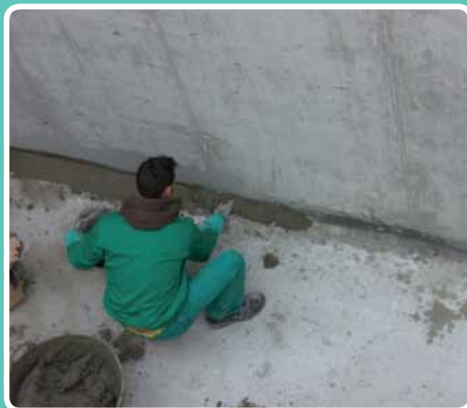
(Revestimiento cementoso) Mortero tixotrópico. IMES-API Ayuntamiento de Málaga
