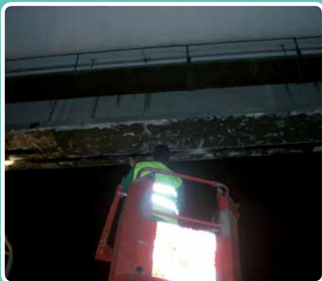
(Refuerzo con fibra de carbono) Superficie lijada, imprimada. API Conservación, Málaga
