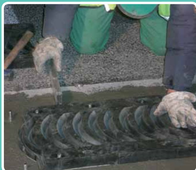
(Aplicación de mortero de nivelación) Nivelando la junta para su fijación. API Movilidad, GRANADA
