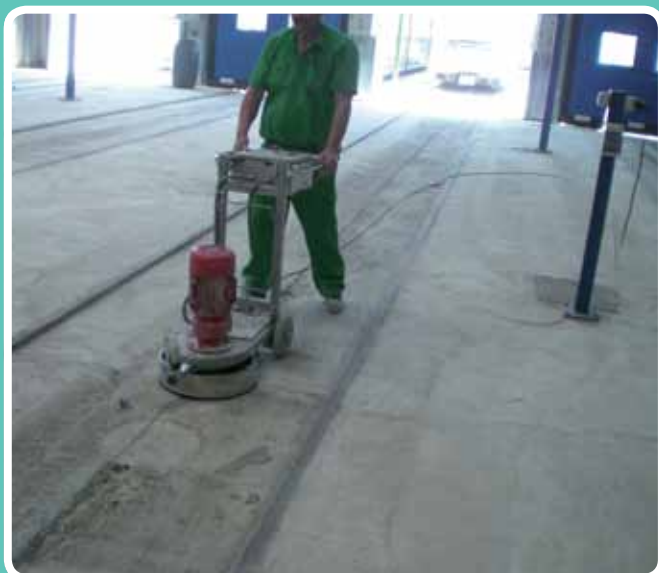
(Pavimentos decorativos) Lijando superficie. Recuperaciones Ballesteros, nueva sede
