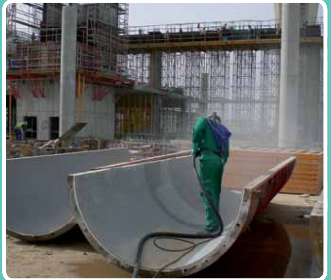
Chorreando moldes. Ampliación Aeropuerto de Málaga
