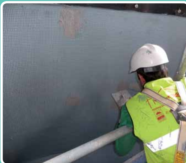
(Depósitos de revestimiento epoxi) Mortero epoxi. Nueva Central de Ciclo Combinado de Málaga
