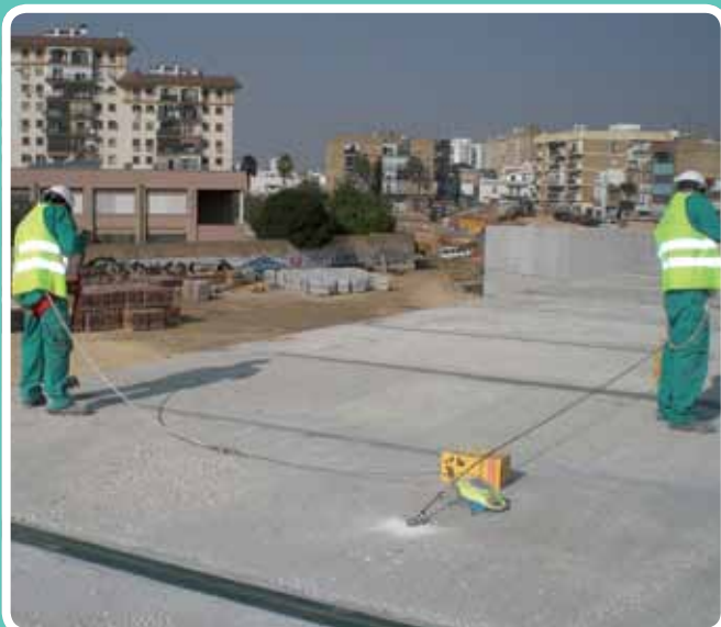
Tratamiento de cajones prefabricados. UTE Metro de Sevilla
