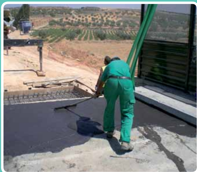
(Aplicación de mortero impermeable) Impermeabilización de tableros. Autovía de Alanzora
