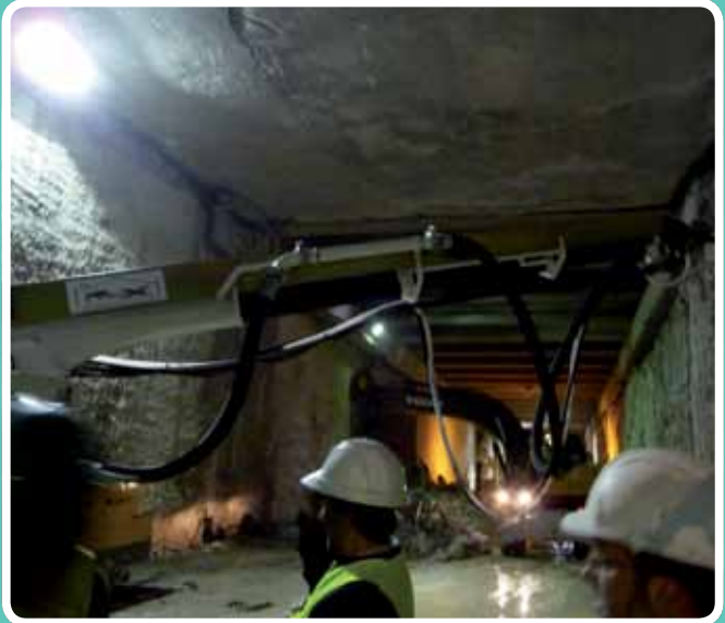
(Robot de gunita) Posicionando la proyección
