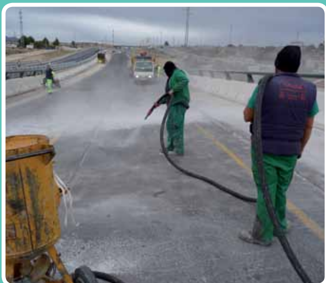
(Limpieza de hormigón) Chorreando hormigón. Línea de Alta Velocidad Plataforma de Levante
