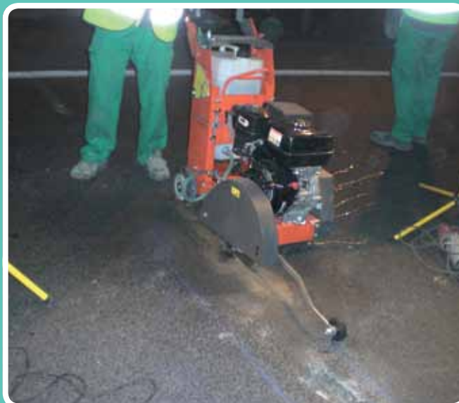
(Corte y cajeo) Comenzando el corte. API Málaga
