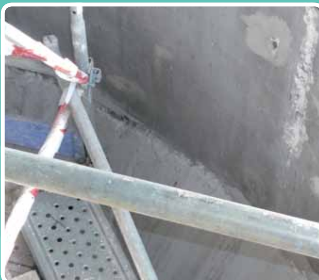
(Depósitos de revestimiento epoxi) Saneo hormigón. Nueva Central de Ciclo Combinado de Málaga
