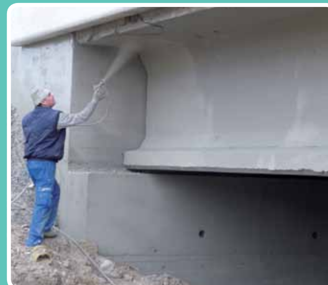
Tratamiento anticarbonatación. UTE Albox
