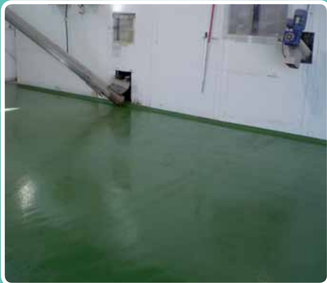
(Pavimentos industriales) Pavimento epoxi. Industria Cárnica, Huelva
