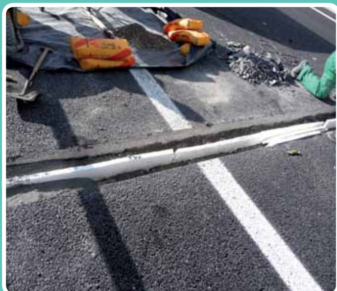
(Aplicación de mortero de nivelación) Comenzando la aplicación. API Movilidad, GRANADA
