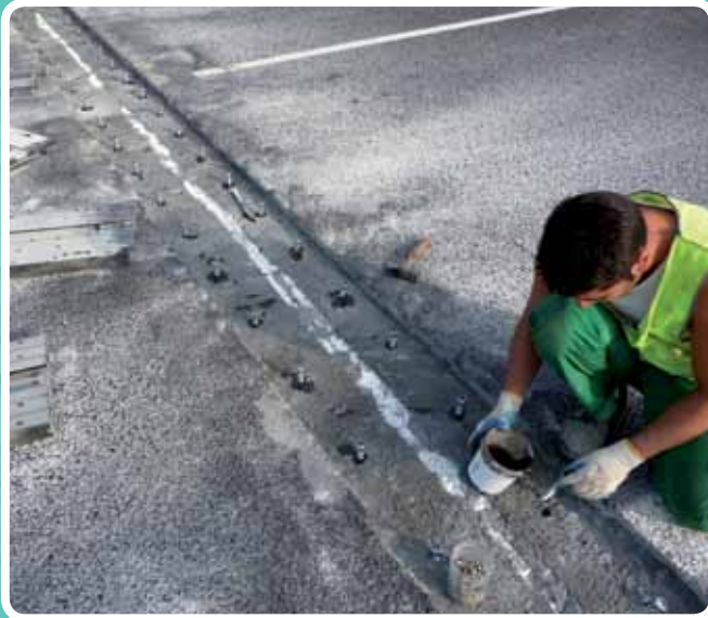
(Anclado con resina epoxi) Colando resina. UTE Cuellar, Segovia
