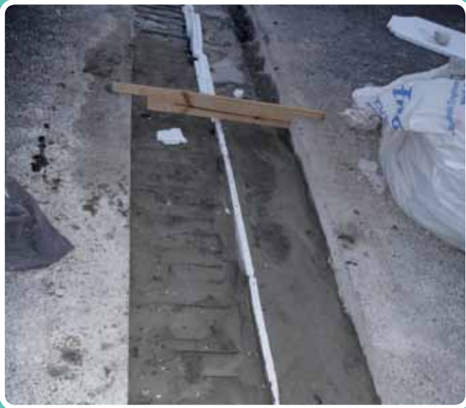
(Aplicación de mortero de nivelación) Mortero nivelación. Ayto. de Montoro, Córdoba
