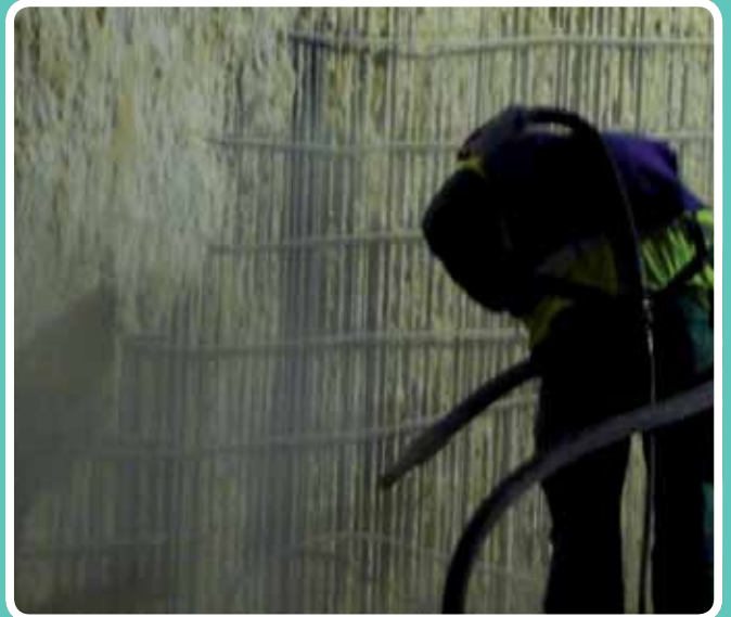
Limpieza mediante chorro de óxido. Integración del AVE en Málaga
