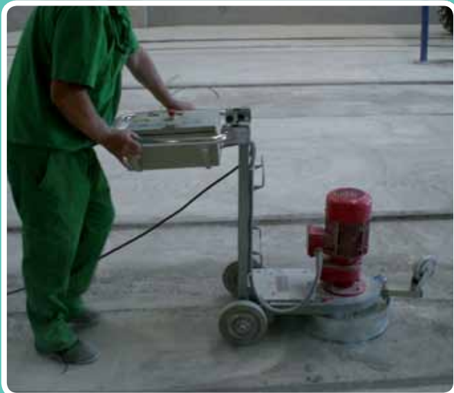
(Pavimentos industriales) Lijando la calle. Industria Cárnica, Huelva
