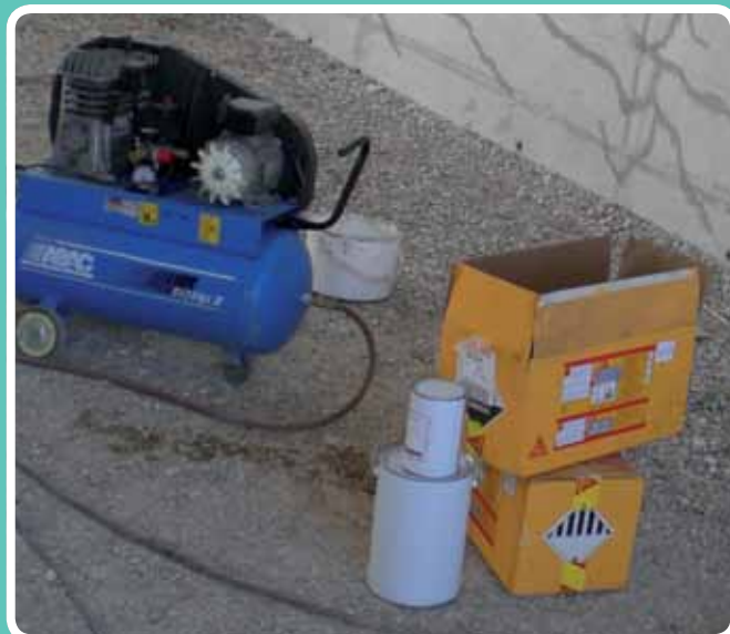
Equipo de inyección. Ferrovial Montoro, Córdoba
