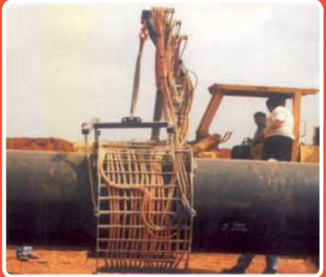
Tratamiento de juntas de gaseoducto. Calentamiento
