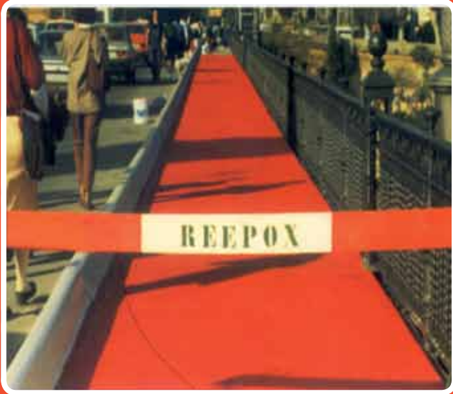
Pavimentación epoxi en aceras del Puente de Triana (Sevilla)
