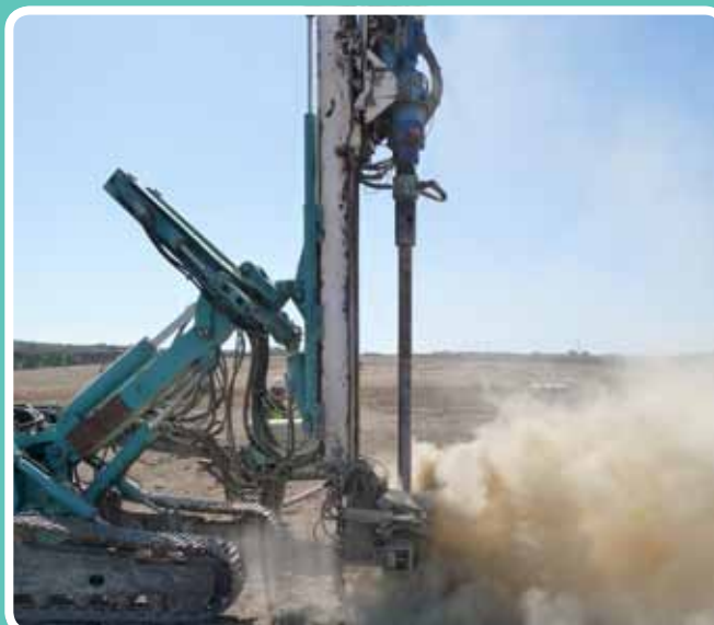
Perforaciones cimentacion planta fotovoltaicaalconera (Zafra)
