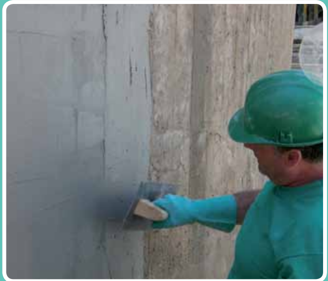
Aplicando el mortero hasta 3 mm. Siderúrgica Sevillana
