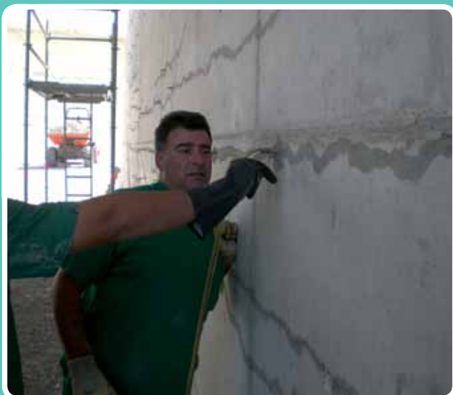
Replanteo de inyectores. Ferrovial Montoro, Córdoba
