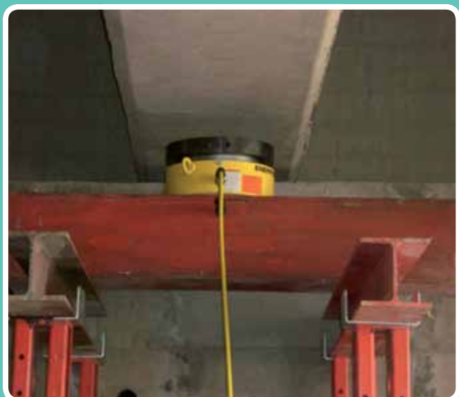
Replanteo de inyectores
