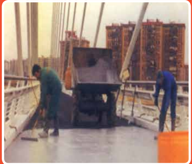
Pavimentación paseo central. Puente de El Alamillo (Sevilla)
