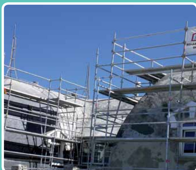
Reparación de cubierta. Albergue Militar Sierra Nevada
