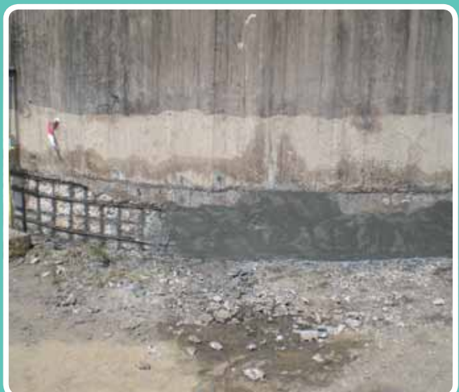
Restaurando la armadura. Siderúrgica Sevillana
