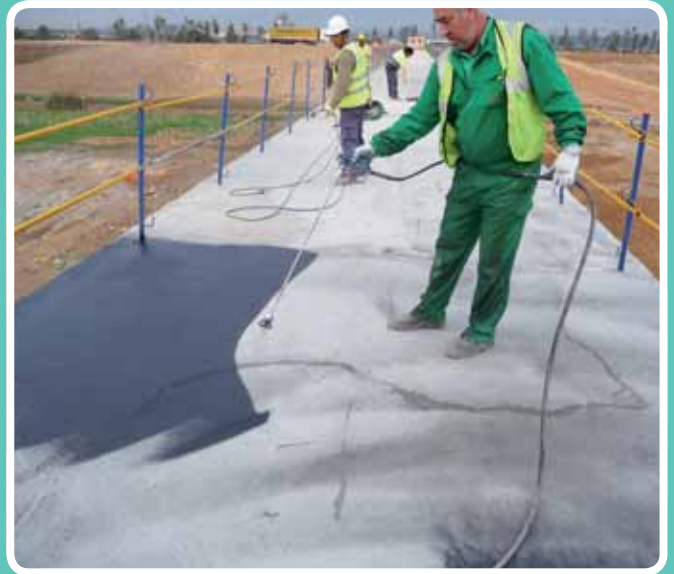
Impermeabilización pasarelas peatonales con resina Sando (Sevilla)
