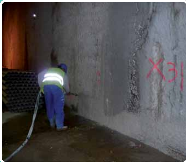
(Proyección de mortero ignífugo) Proyectando mortero ignífugo. Integración del AVE, Málaga, tramo Antequera-Málaga
