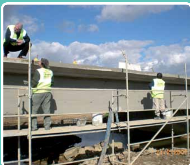
Reconstrucción de volúmenes. Rehabilitación Río Ebro
