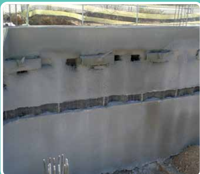
(Maquinaria estática / vía húmeda) Zona alta de obra. Grupo Terratest, Madrid
