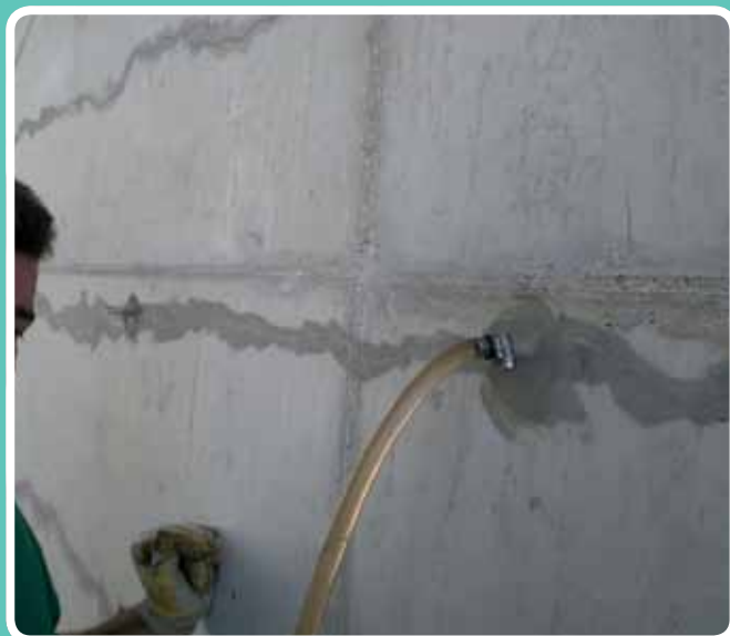
Inyectando resina. Ferrovial Montoro, Córdoba
