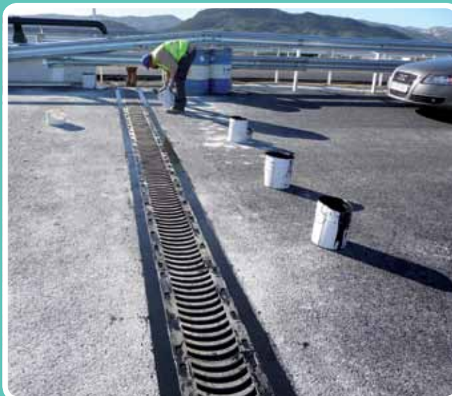
(Relleno banda transición y par de apriete) Alineación módulos con la banda Autovía de Almazora
