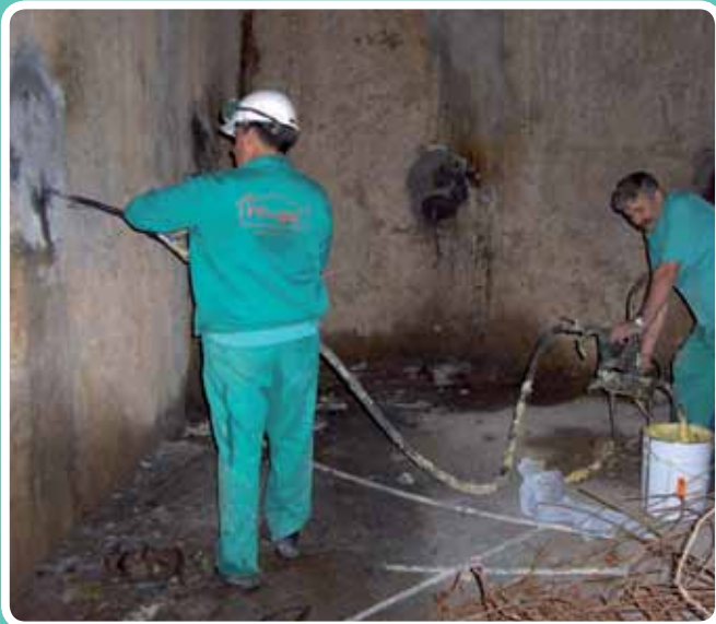
(Sellado de anclajes) Equipo de inyección en anclajes. Parlamento de Andalucía, TECONSA
