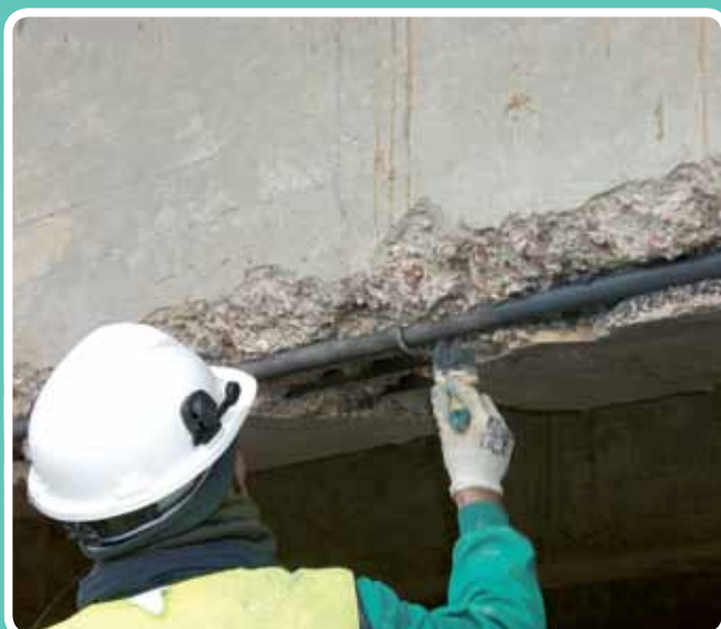
Pasivación armaduras. Api Conservación Málaga
