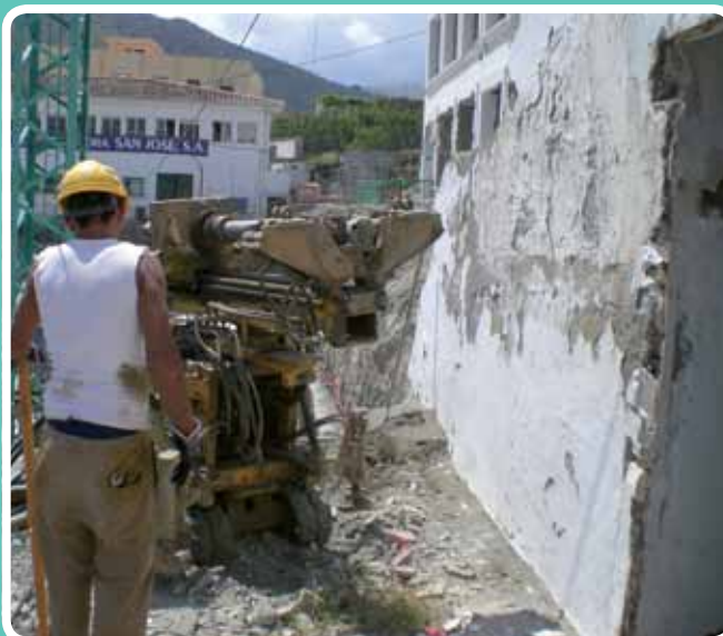
Desplazamiento reducido. Obra Const. San José, Albuñol, Granada
