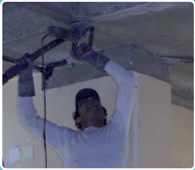
(Refuerzo con fibra de carbono) Lijando la superficie.
