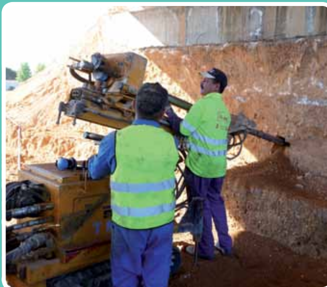
Bulonados especiales para estabilizacion de taludes en estribo de paso superior en autovia A-40 en tarancon (Cuenca)
