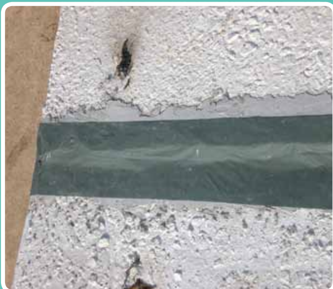
Juntas autoadherente. UTE Metro de Sevilla
