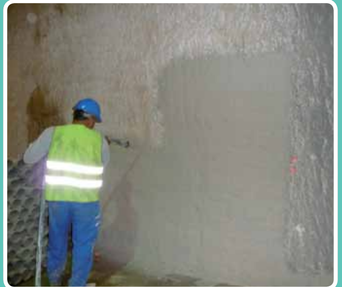
(Proyección de mortero ignífugo) Soterramiento AVE. Integración del AVE, Málaga, tramo Antequera-Málaga
