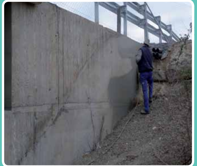
(Revestimientos anticarbonatación) Autovía Almazora
