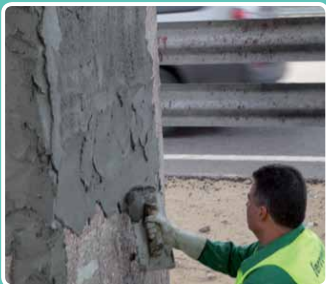
Mortero inicial. Dragados, Málaga
