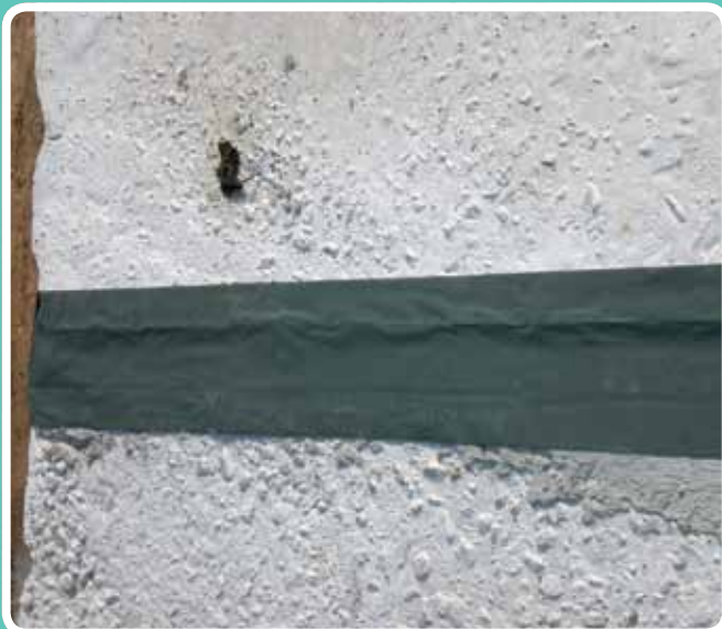
Junta colocada. UTE Metro de Sevilla
