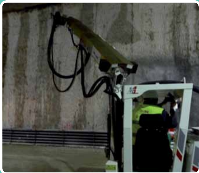
(Robot de gunita) Recubriendo armadura vista
