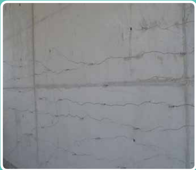
Replanteo de inyectores. Ferroviario Montoro, Córdoba
