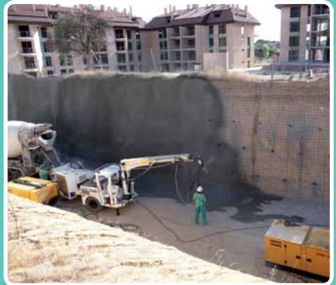
Estabilizacion de talud en calle de colegio de Bobadilla del Monte (Madrid)
