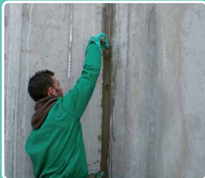
(Revestimiento cementoso) FCC- Confección de media caña Decantadora de El Trapiche, Málaga
