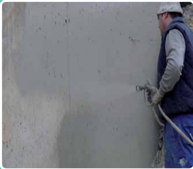
(Revestimientos anticarbonatación). Autovía Almazora
