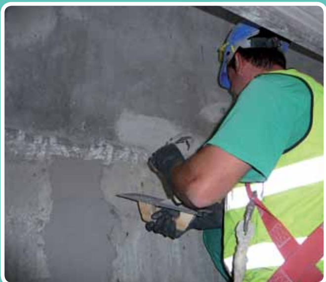
(Depósitos de revestimiento epoxi) Aplicando revestimiento epoxi. Nueva Central de Ciclo Combinado de Málaga
