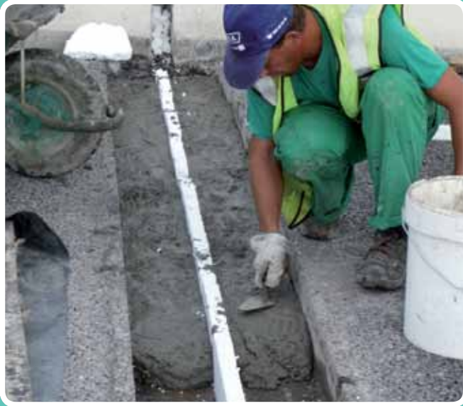
(Aplicación de mortero de nivelación) Fase de aplicación. ALDESA, Málaga
