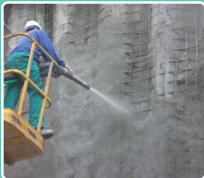
(Maquinaria estática / vía seca) Gunita con 400 kg cemento. Estación de Cartama, Málaga
