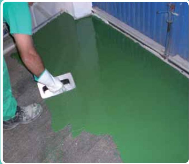
(Pavimentos industriales) Aplicación epoxi. UTE Metro de Sevilla
