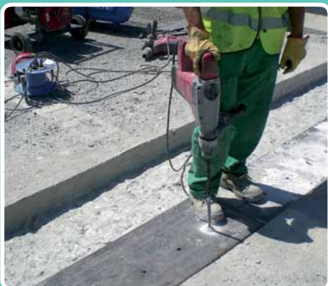
(Replanteo de perforaciones y limpieza) Previamente a colocación de junta
