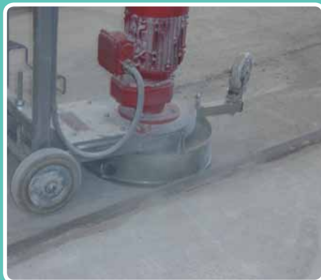
(Pavimentos decorativos) Lijado mecánico. Recuperaciones Ballesteros, nueva sede
