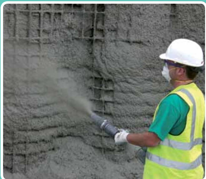
(Maquinaria estática / vía húmeda) Proyección sobre pilotes. Nueva plataforma Aeropuerto de Málaga
