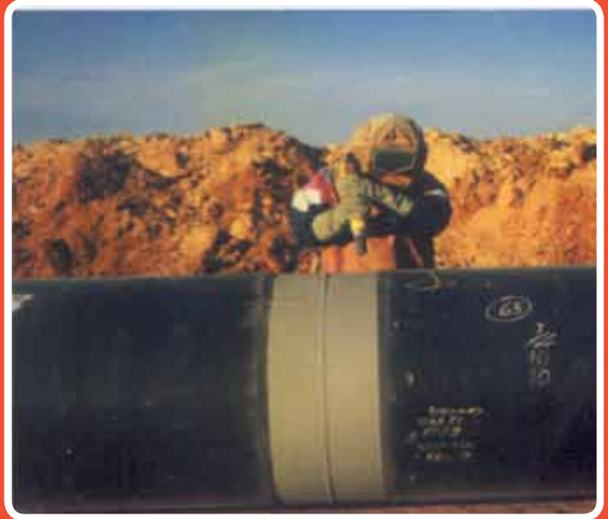
Tratamiento de juntas de gaseoducto. Chorro de arena
