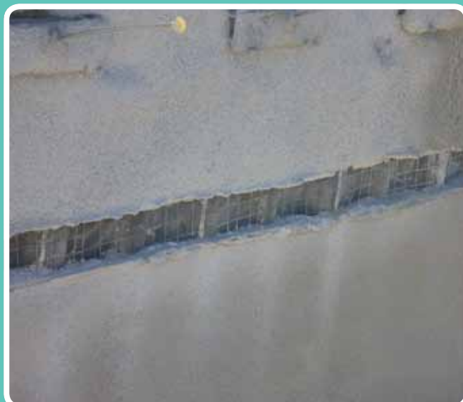
(Maquinaria estática / vía húmeda) Gunita como acabado CORSAN CORVIAN, Pizarra, Málaga
