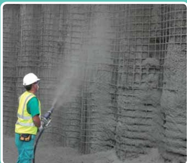
(Maquinaria estática / vía húmeda) Gunita manual pilotes. UTE San Fernando, soterramiento línea férrea
