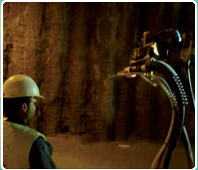
(Robot de gunita) Gunitando robot
