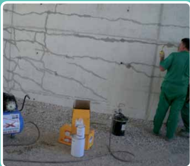
Equipo de inyección. Ferrovial Montoro, Córdoba
