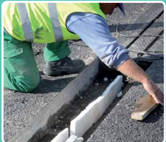
(Aplicación de mortero de nivelación) Colocación porexpan SAFYR Acceso al Puerto de Málaga
