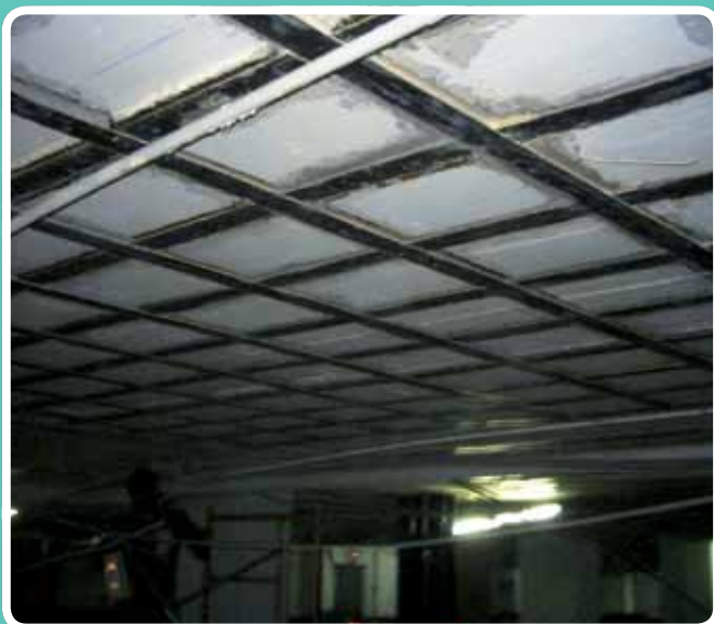
(Refuerzo con fibra de carbono) Fibra de carbono cruzada. Estadio Carranza
