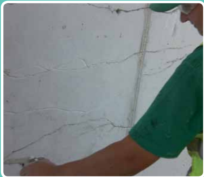
Una vez cajeadas. Ferroviario Montoro, Córdoba
