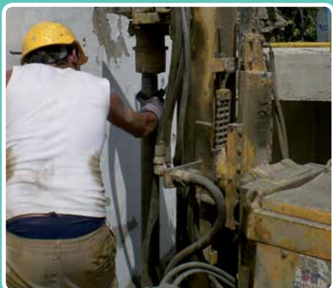
Colocando varillaje. Obra Const. San José, Albuñol, Granada
