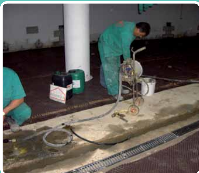
(Sellado de anclajes) Equipo inyectando. Hotel Montemálaga, Dragados
