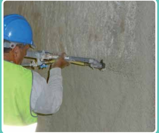
(Proyección de mortero ignífugo) Proyección sobre muro pantalla. Integración del AVE, Málaga, tramo Antequera-Málaga
