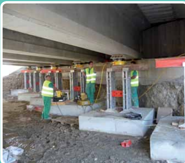
Equipo de inyección
