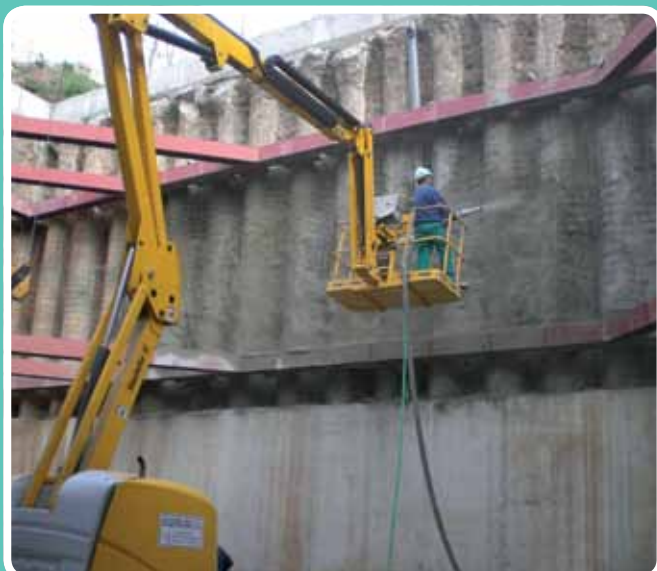
(Maquinaria estática / vía seca) Proyección en altura. Base Aérea Morón de la Frontera
