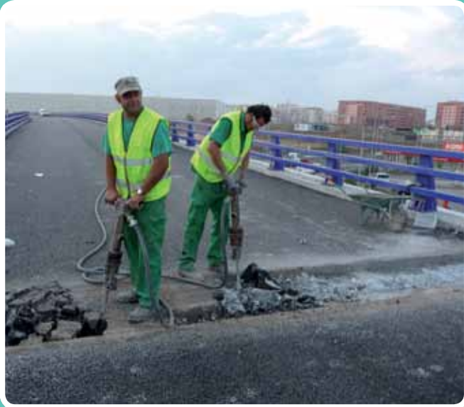
(Corte y cajeo). ALDESA, Nuevo acceso Barriguilla, Málaga
