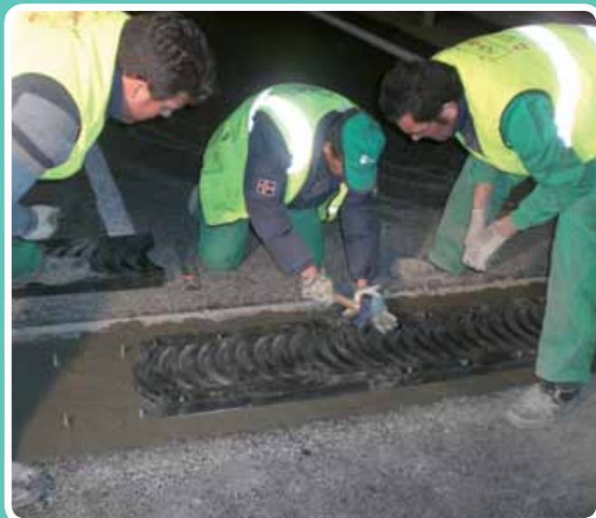
(Aplicación de mortero de nivelación) Junta de movimiento especial API Conservación,
