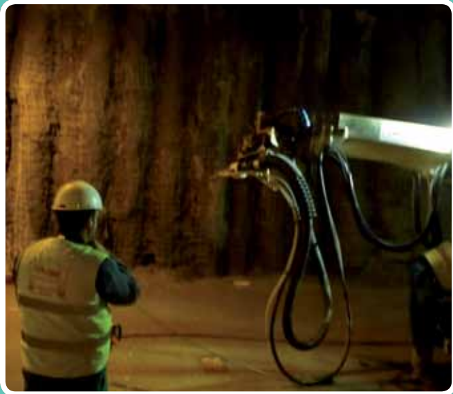
(Robot de gunita) Gunitando robot
