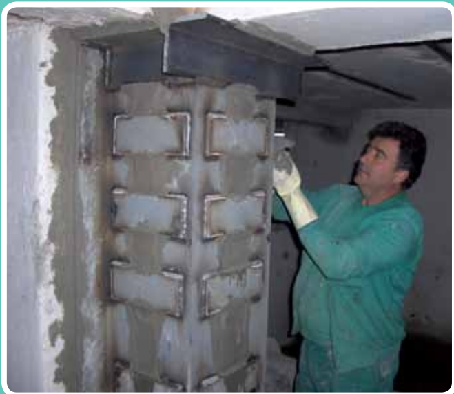
(Refuerzo con elemento metálico) Relleno para monolitismo. Constructora San José, C/ Don Fadrique, Sevilla
