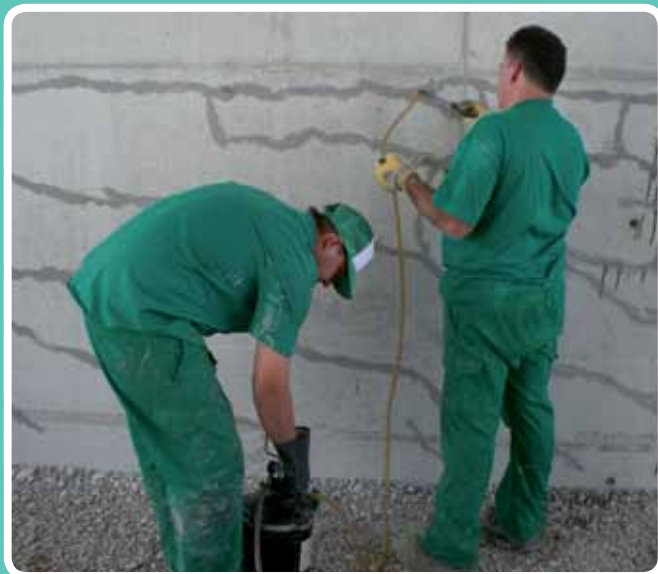
Comprobando entrada. Ferroviario Montoro, Córdoba
