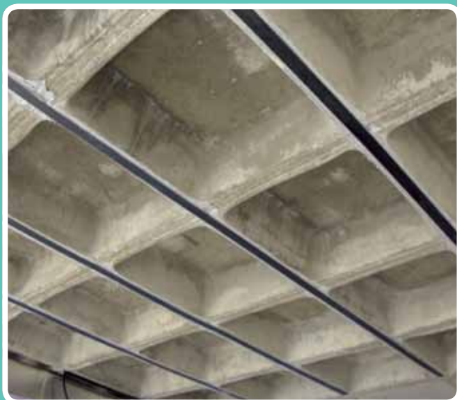
(Refuerzo con fibra de carbono) Fibra de carbono recién colocada. Estadio Carranza
