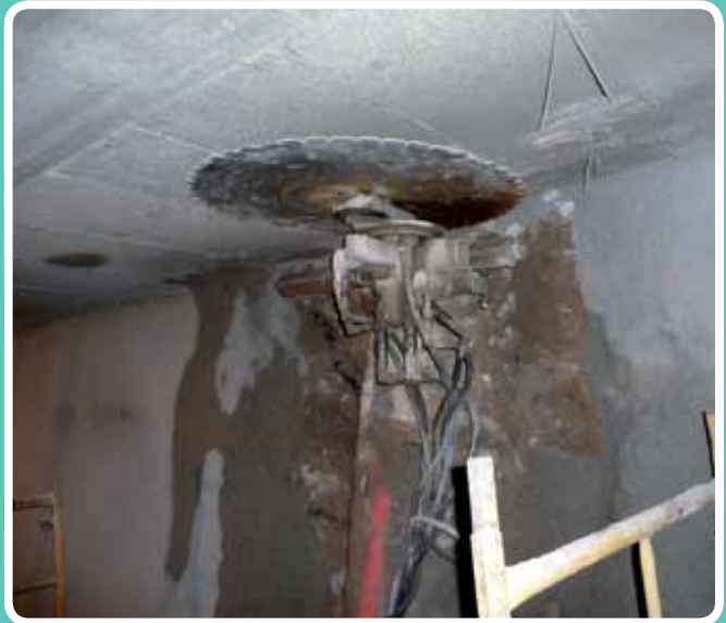
(Máquina rural) Corte superior de pilotes. IFC. C/ Juan Rabadán (Grupo Terratest)
