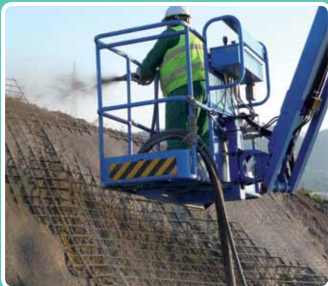
(Maquinaria estática / vía húmeda) Proyectando en brazo coronando talud. Estación de Cartama, Málaga
