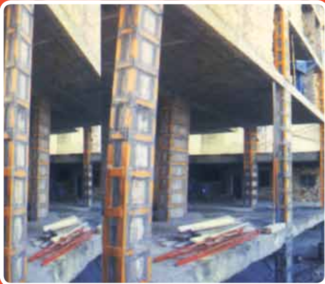
Refuerzo de estructura. Edificio de Viviendas
