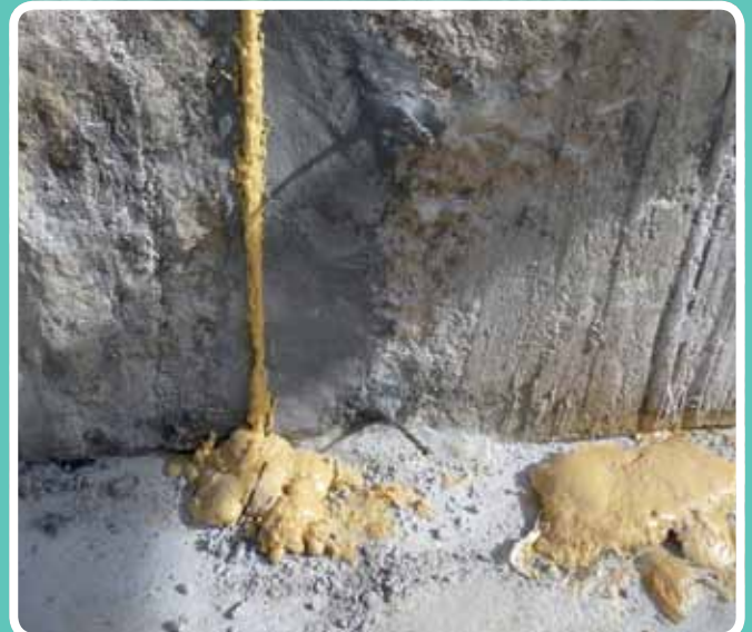
(Juntas muro de pantalla) Junta acabada. UTE Metro de Sevilla
