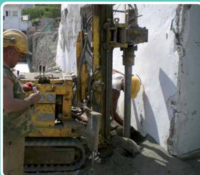
Perforando. Obra Const. San José, Albuñol, Granada
