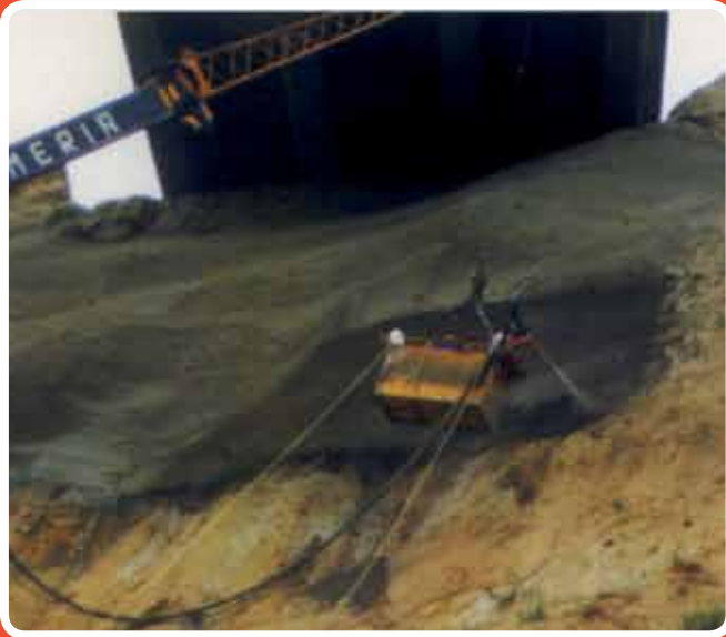
Bulonado y gunitado de taludes. Autovía del Sol
