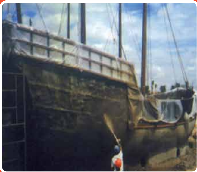
Construcción de carabelas mediante gunitado. Isla Mágica (Sevilla)
