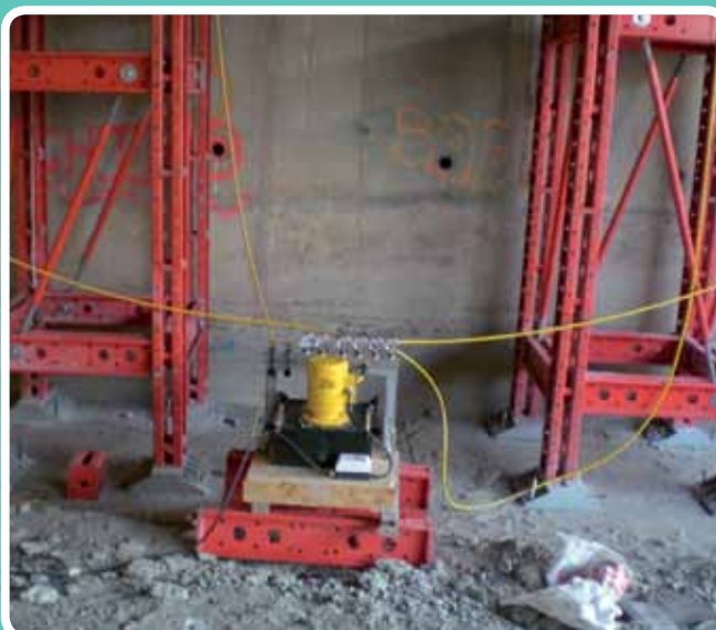
Inyectando resina
