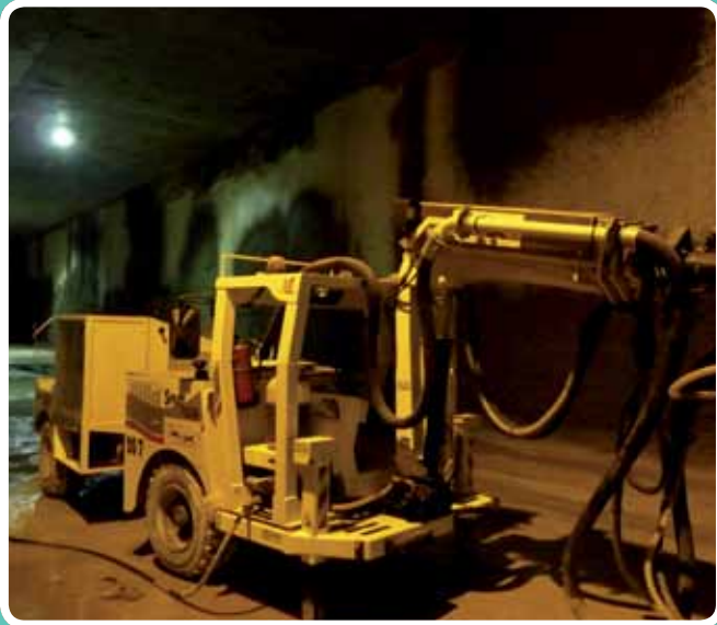
(Robot de gunita) Maquinaria robotizada hidráulica
