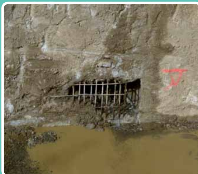
(Juntas muro de pantalla) Vía de agua. Grupo Terratest C/ Armendáriz
