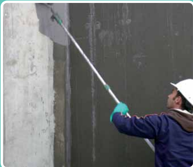
(Revestimiento cementoso) Aplicando membrana. Decantadora de El Trapiche, Málaga
