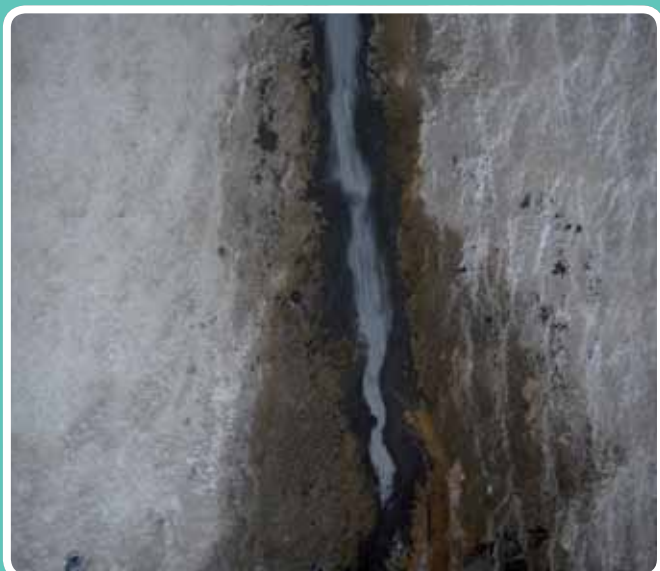
(Juntas muro de pantalla) Junta tratada. CIMUR Aparcamiento Triana, Sevilla
