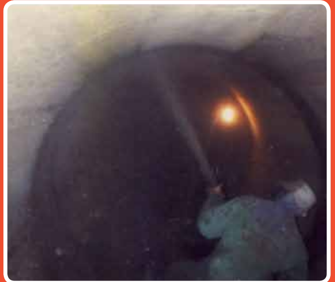
Gunitado de galería. Canal de la Minilla
