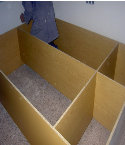
Posteriormente se colocan las divisiones interiores en caso de que la distribución del armario lo requiera.
