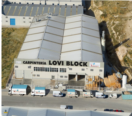
Vista general de nuestras instalaciones.
