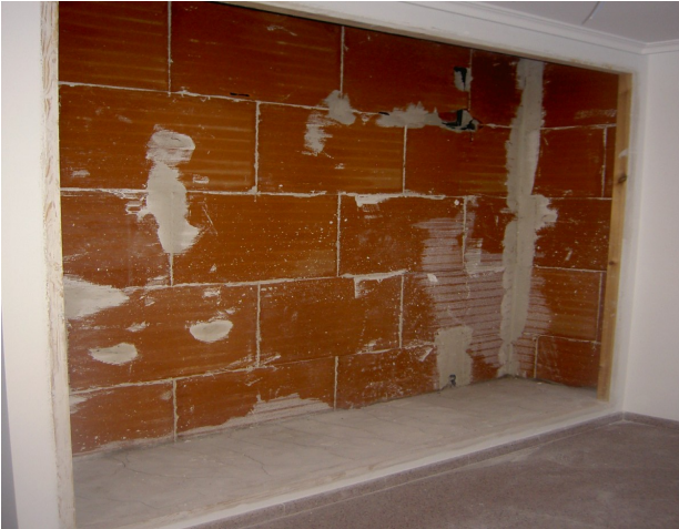
Hueco de armario, con premarco, paredes sin yeso ni pintura, techo sin escayola, suelo a ras de premarco
