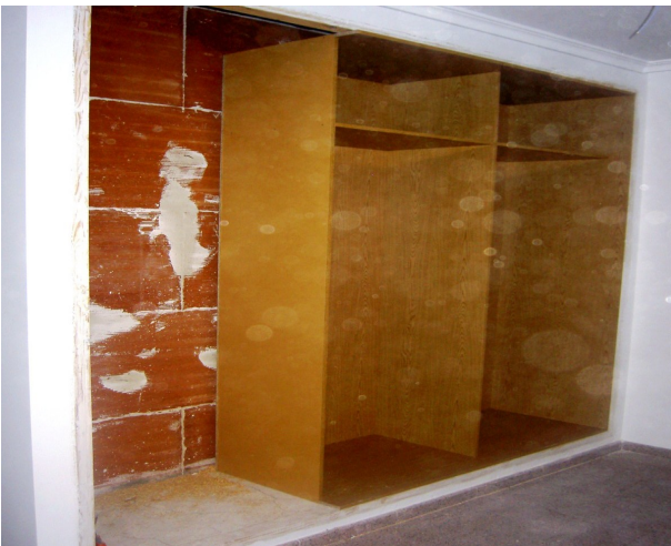
El módulo es introducido dentro del hueco, se aploma y se fija al premarco con tornillos. Posteriormente se colocan las puertas y los tapajuntas.
