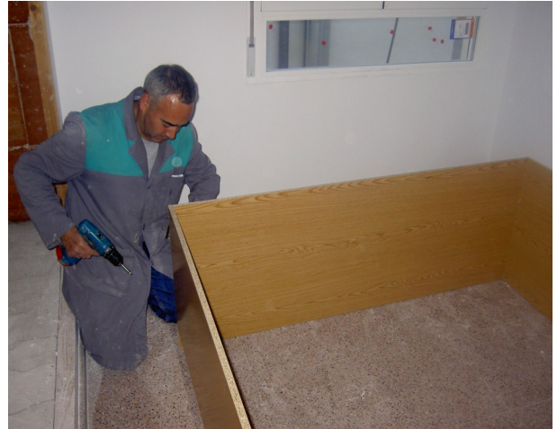
Se procede a montar el módulo, primero los costeros y las bases.
