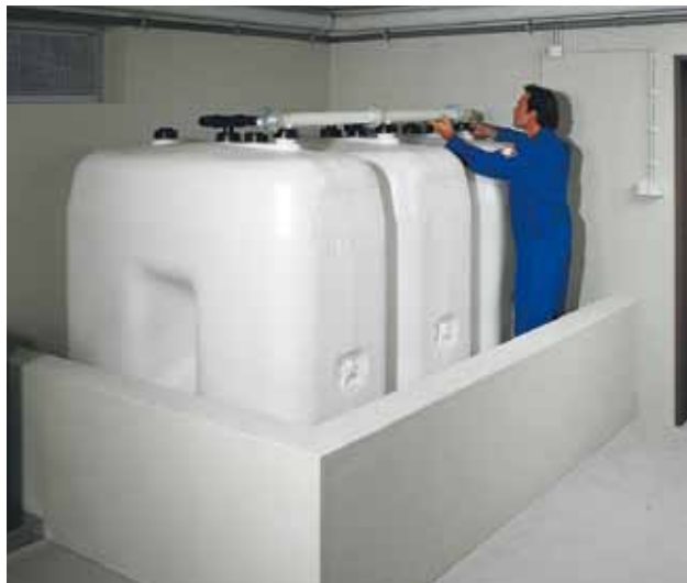
Instalación de los depósitos en un cubeto de obra.
