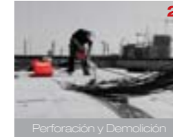
Perforación y Demolición
