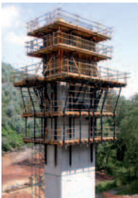
Pilas del Viaducto de Candaliera, Asturias, España
