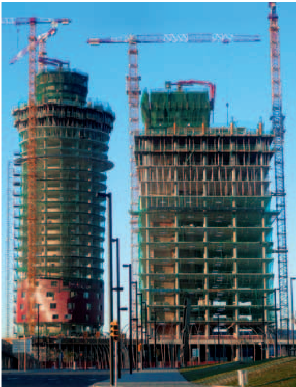
Sistemas Autotrepantes ATR en Torres FIRA, Barcelona, España
